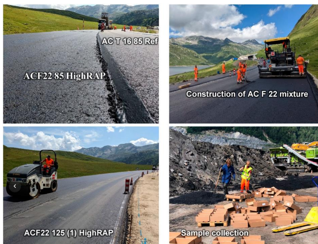
Figura 15 – Construção da seção teste no Passo de Lukmanier (Fonte: Zaumanis et al. (2024))
