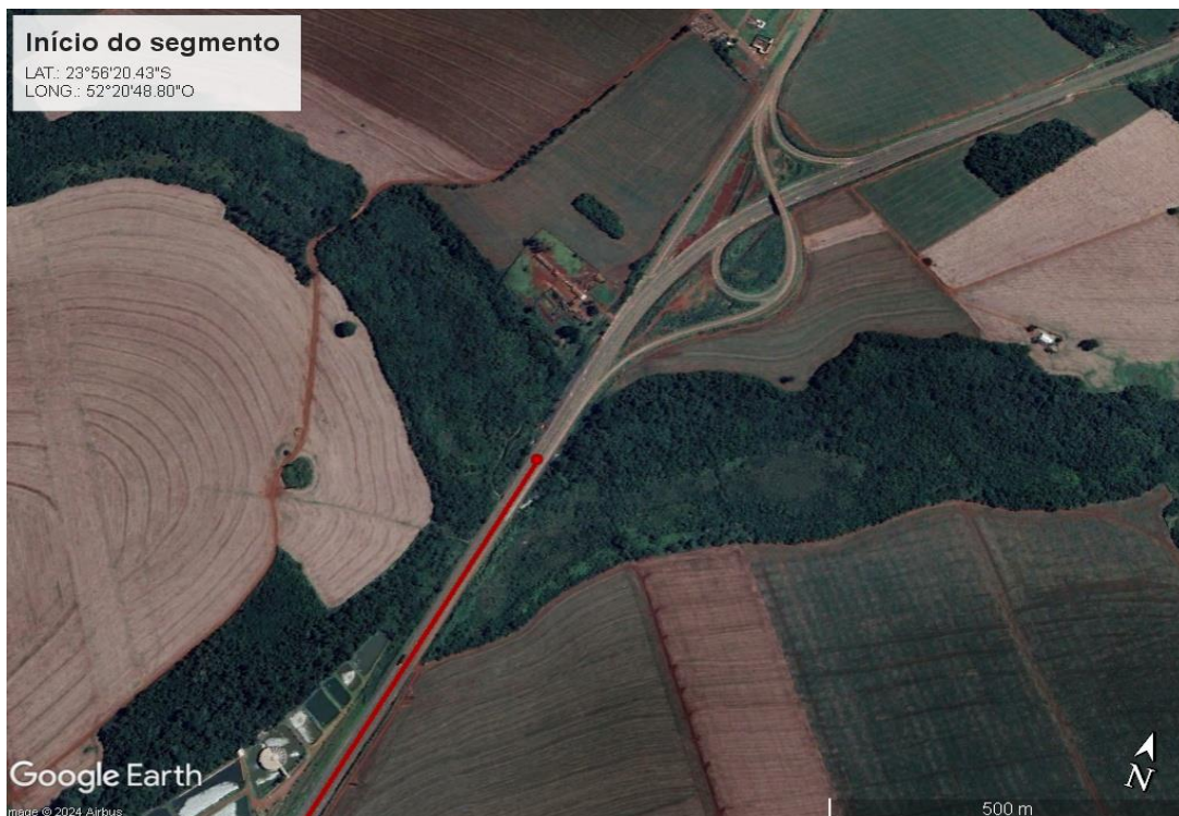
Figura 2 - Início do Segmento da PR-158
