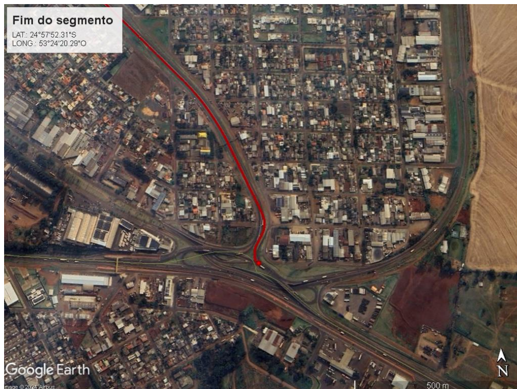
Figura 11 – Final do Segmento da BR-467/PR
