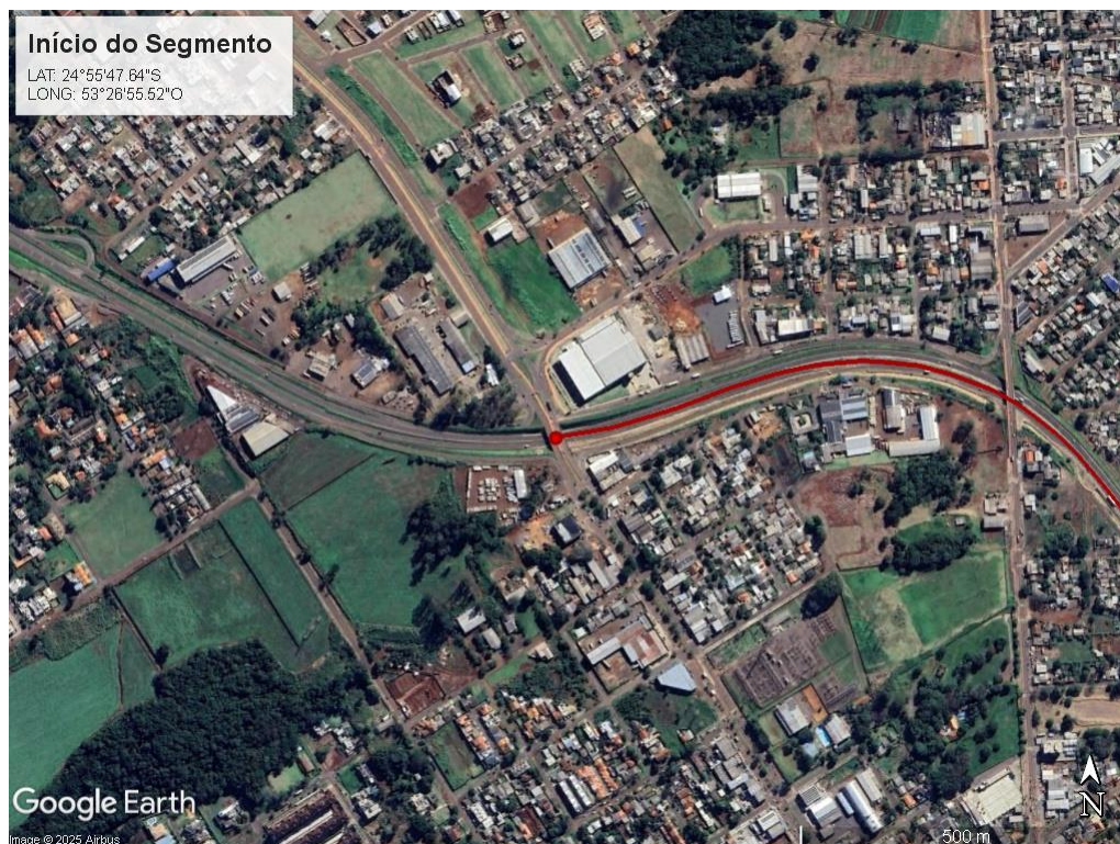
Figura 12 – Início do Segmento da PR-467
