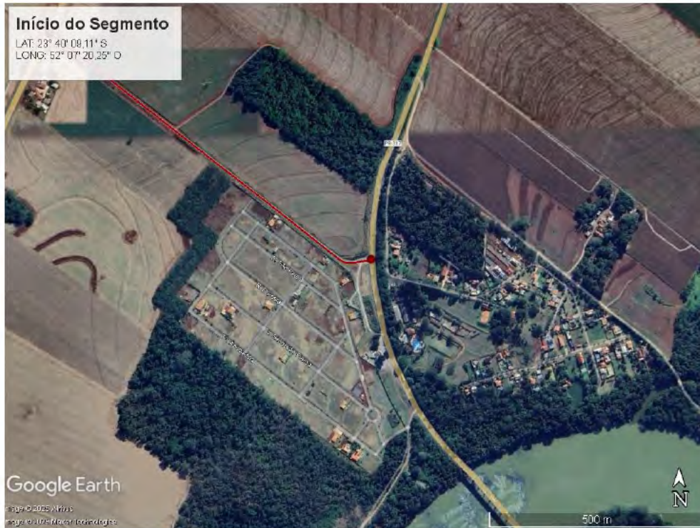
Figura 20 - Início do Segmento da PR-978 – Entroncamento com a PR-317
