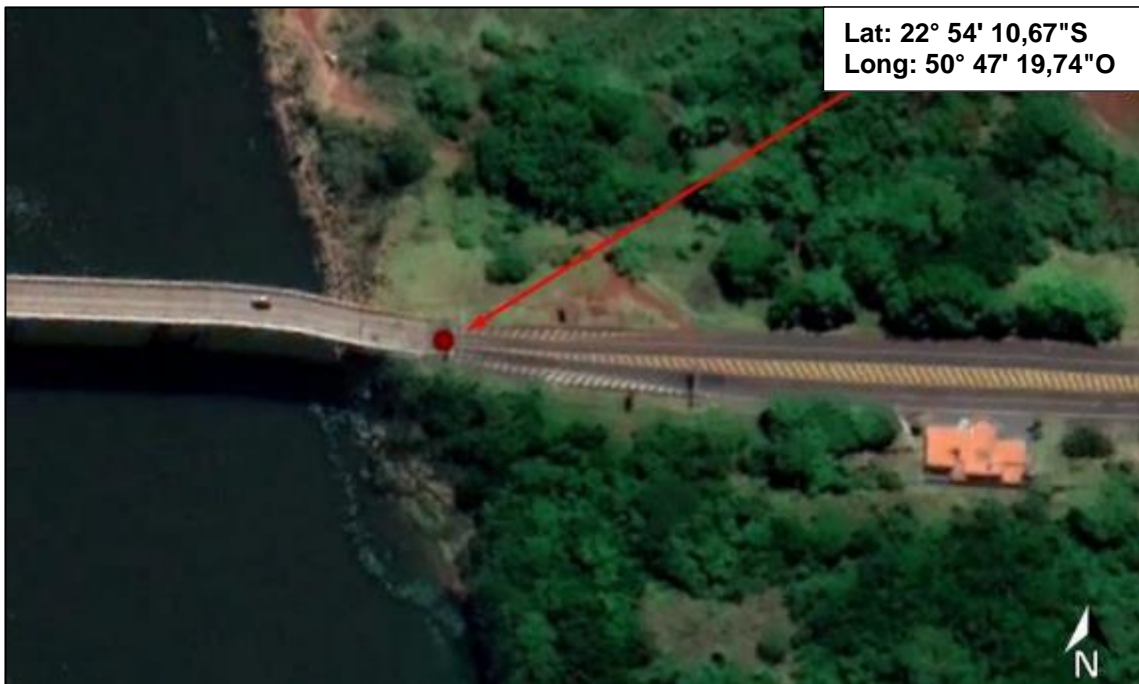
Figura 21 - Início da Ponte do Rio Paranapanema em São Paulo
