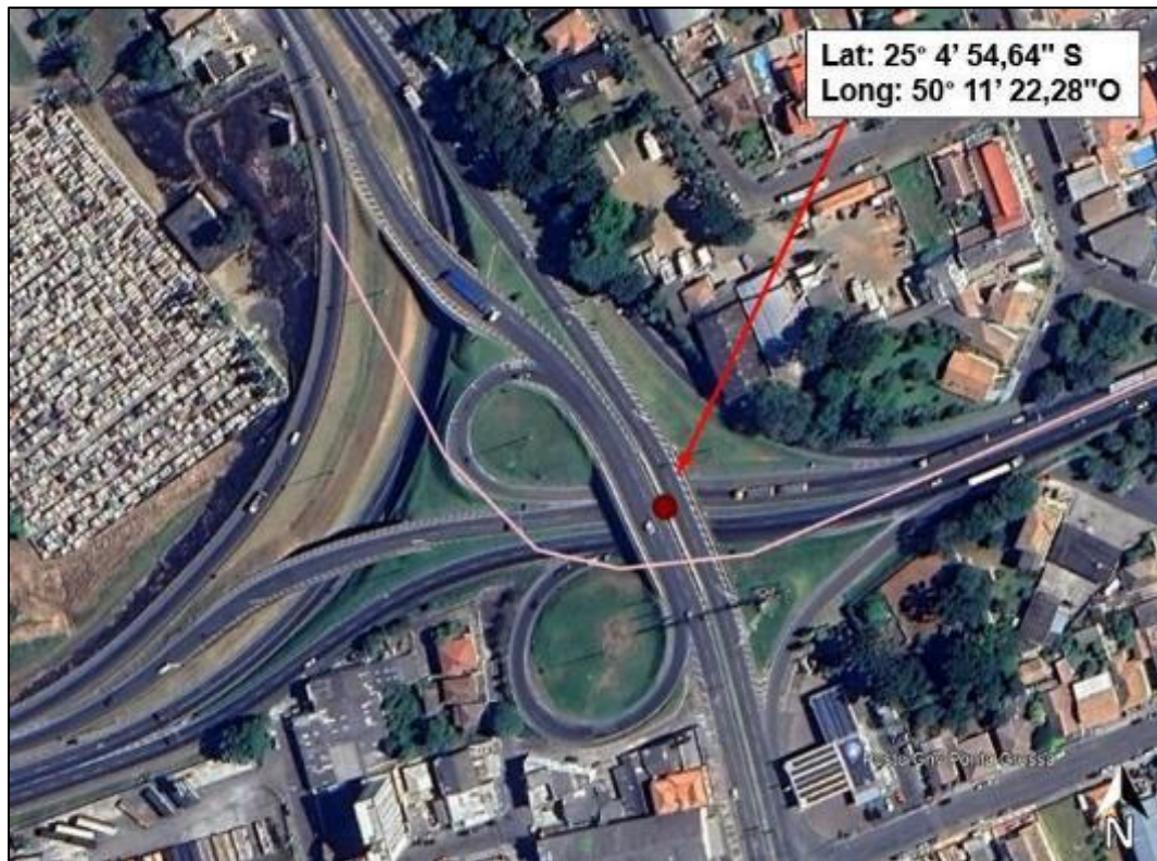
Figura 7 - Fim do Segmento no entroncamento com a BR-376
