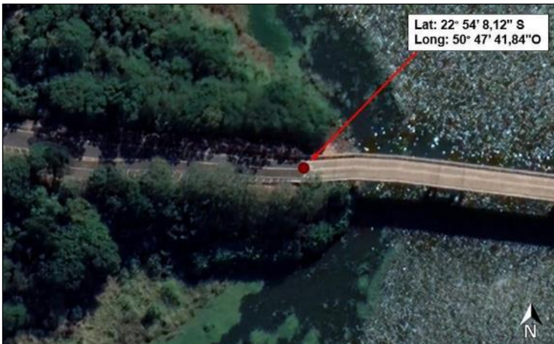
Figura 22 - Fim da Ponte sobre o Rio Paranapanema no Paraná
