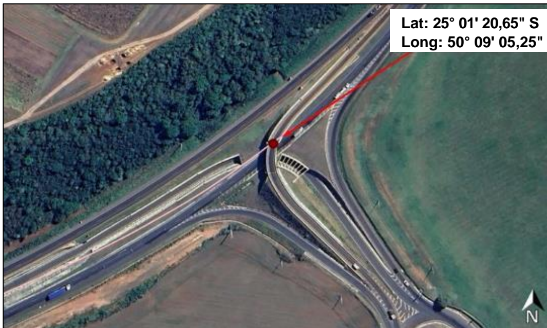
Figura 6 - Início do segmento no entroncamento com a PR-151
