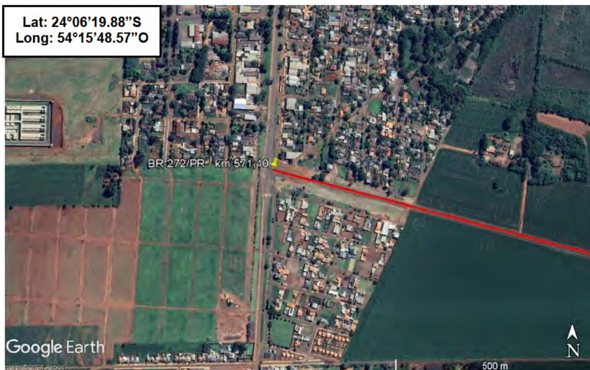
Figura 3 - Fim do Segmento da BR-272/PR - km 571,400
