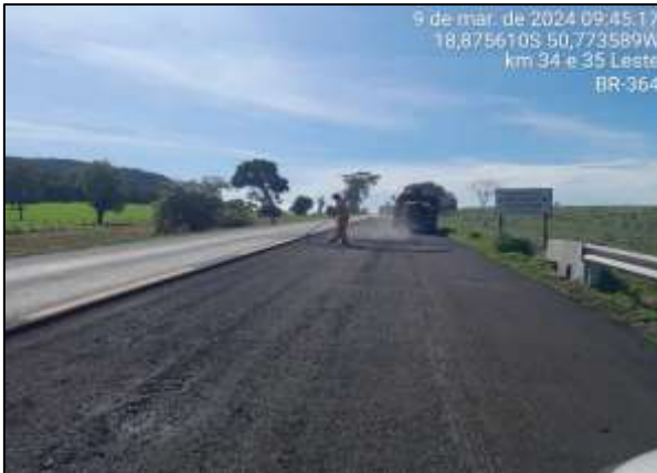
Rodovia BR364/GO – KM 34 ao 35 Leste – Reabilitação do Pavimento
