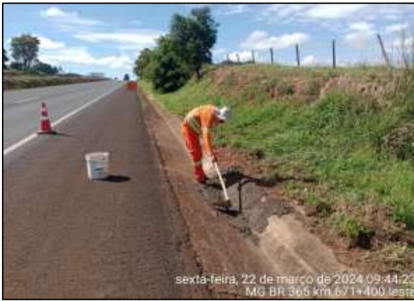
Rodovia BR365/MG – KM 671+400 Pista Leste – Reparo em Sarjeta
