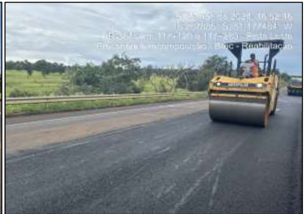
Rodovia BR364/GO – KM 117+200 ao 117+400 Leste – Reabilitação do Pavimento
