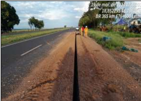
Rodovia BR365/MG – KM 676+600 Leste – Reabilitação do Pavimento - Dreno
