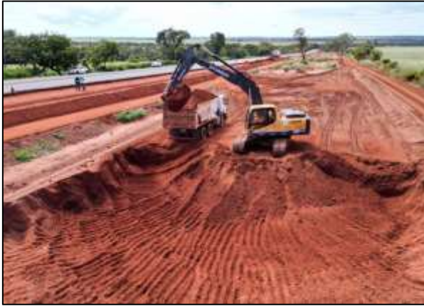
BR-364/GO – KM 129+980 ao 131+910 - Implantação de Acostamento
