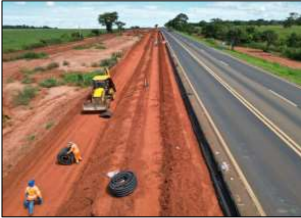
BR-364/GO – KM 129+980 ao 131+910 - Implantação de Acostamento
