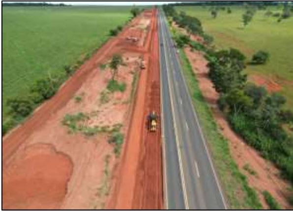
BR-364/GO – KM 129+980 ao 131+910 - Implantação de Acostamento
