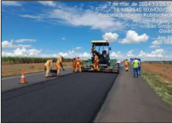
Rodovia BR364/GO – KM 19 – Reabilitação do Pavimento
