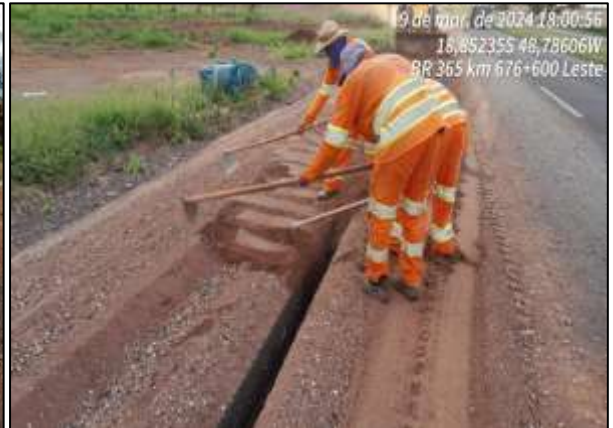
Rodovia BR365/MG – KM 676+600 Leste – Reabilitação do Pavimento - Dreno
