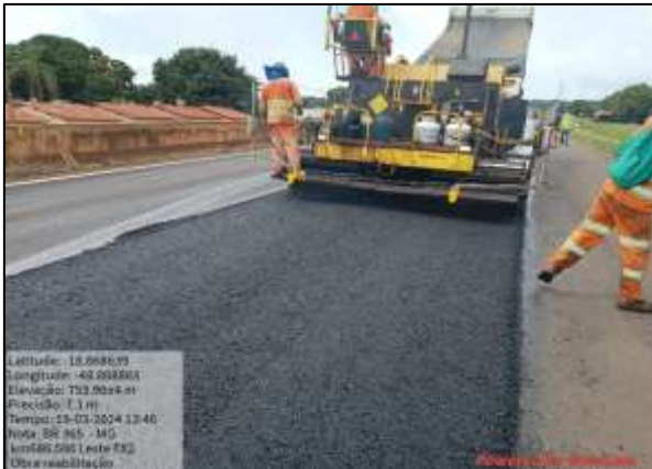
Rodovia BR365/MG – KM 686+580 Leste – Reabilitação do Pavimento
