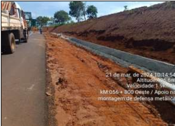
Rodovia BR364/GO – KM 56+800 Pista Oeste – Defesa Metálica
