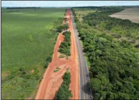
BR-364/GO – KM 129+980 ao 131+910 - Implantação de Acostamento
