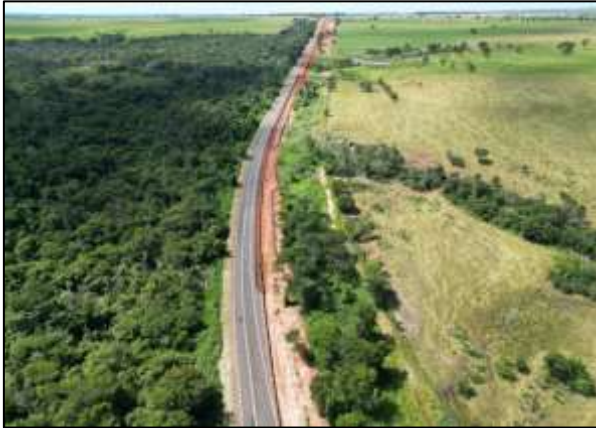
BR-364/GO – KM 133+680 ao 136+295 - Implantação de Acostamento
