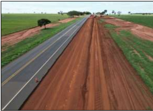
BR-364/GO – KM 133+680 ao 136+295 - Implantação de Acostamento
