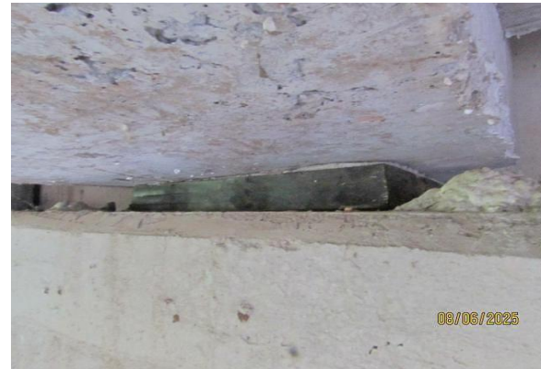
FOTO 10: Aparelho de apoio de neoprene, sob a viga longarina 04, encontro 02, com deficiência de contato.
