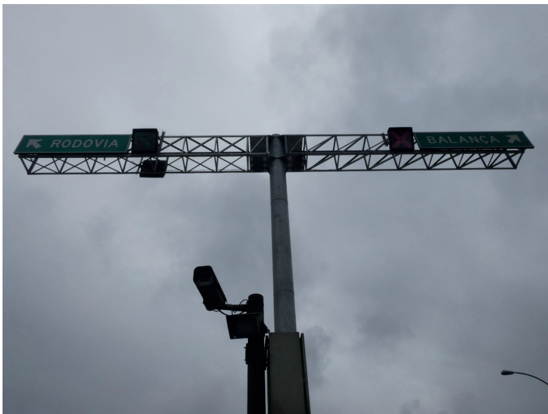
Figura 9 - Câmera de detecção de fuga pela balança seletiva
