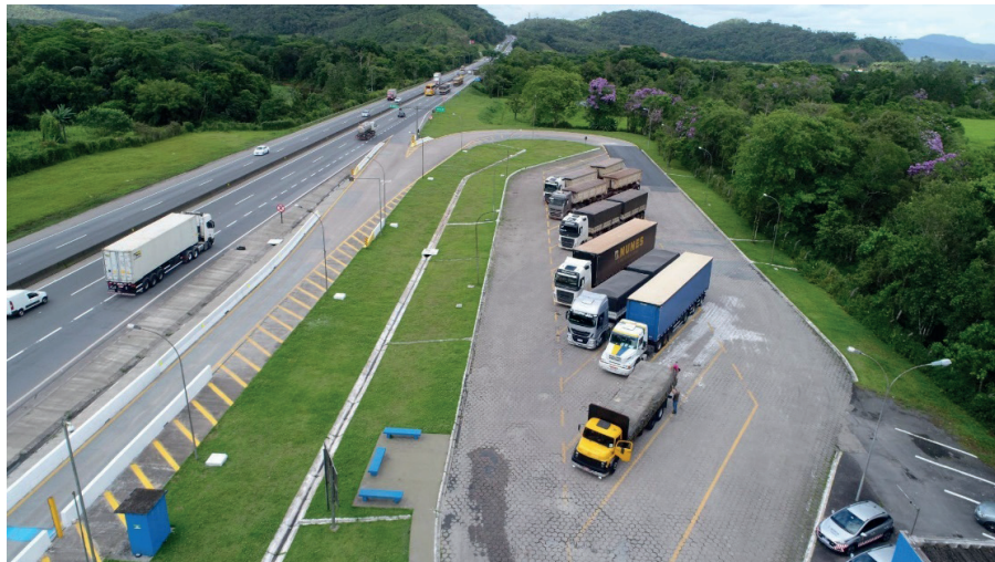
Figura 15 – Pátio de Estacionamento
