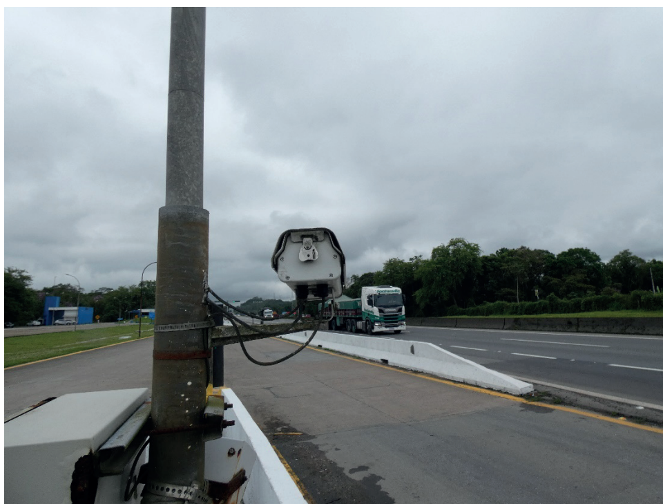
Figura 10 - Câmera para detecção de fuga pela balança de precisão
