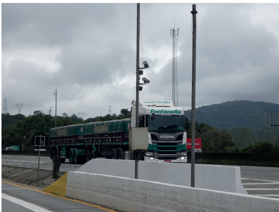
Figura 8 – Câmera de Detecção de fuga pelo By-pass
