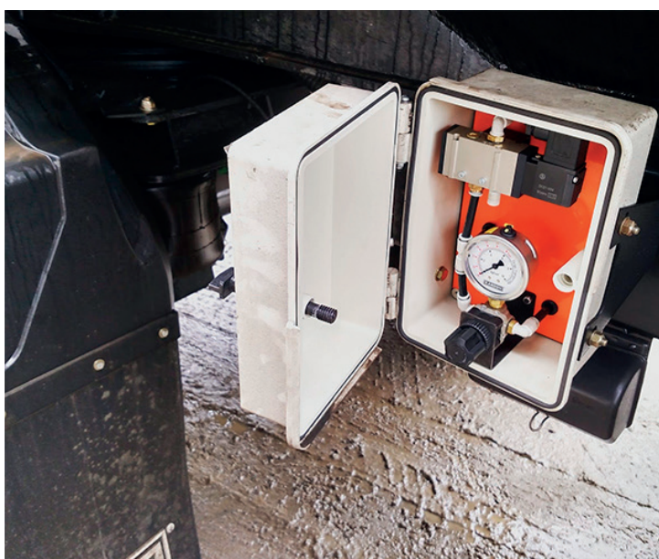
Figura 42 – Sistema de Regulação de Pressão nos Eixos
