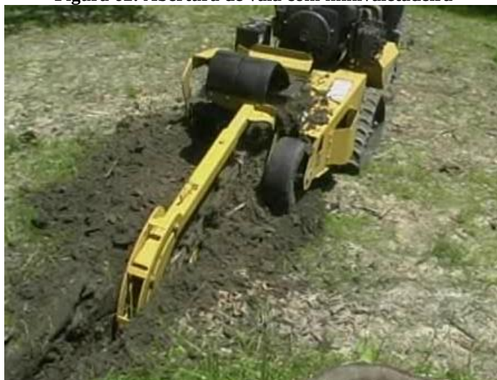
Figura 62: Abertura de vala com minivaletadeira
