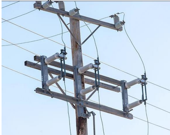
Figura 35: Chave seccionadora
