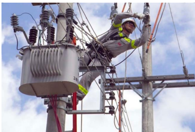
Figura 13: Conexão de cabos de média tensão
