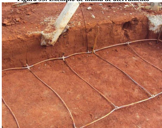
Figura 93: Exemplo de malha de aterramento
