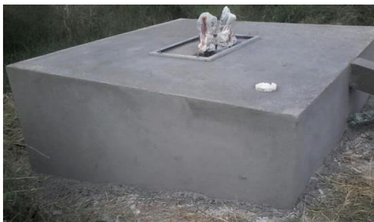
Figura 36: Base de concreto para equipamentos elétricos
