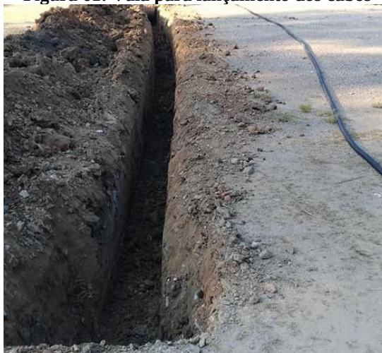
Figura 61: Vala para lançamento dos cabos
