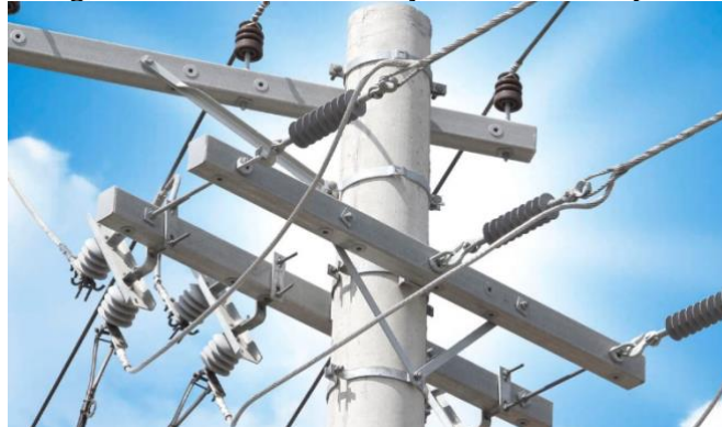
Figura 34: Acessórios de fixação instalados em poste
