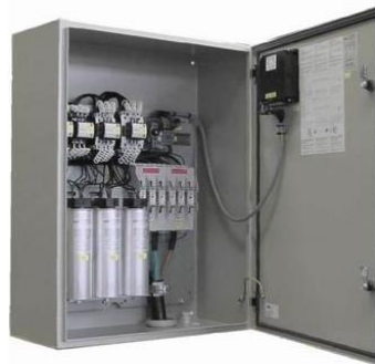
Figura 19: Banco de capacitores de parede
