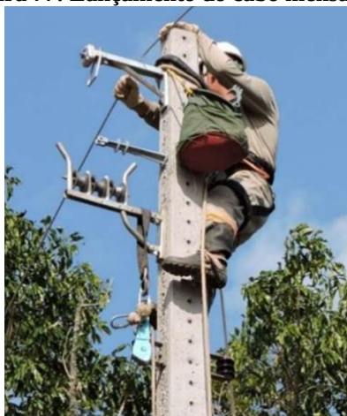
Figura 77: Lançamento do cabo mensageiro
