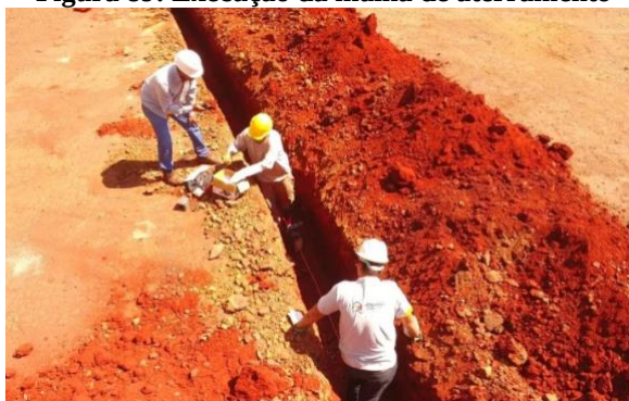
Figura 89: Execução da malha de aterramento
