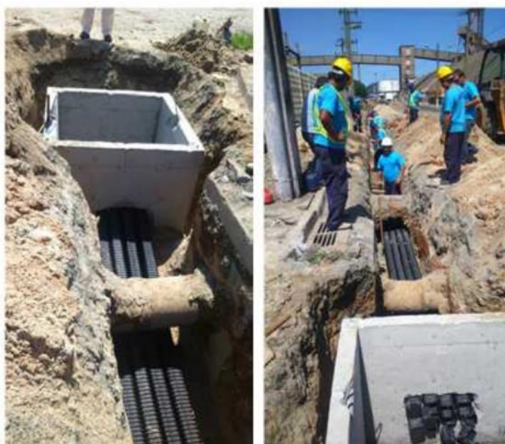
Figura 85: Lançamento de dutos
