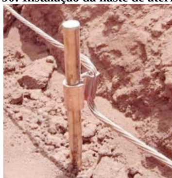
Figura 90: Instalação da haste de aterramento
