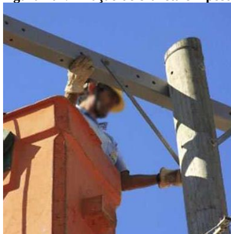
Figura 107: Fixação de cruzeta em poste
