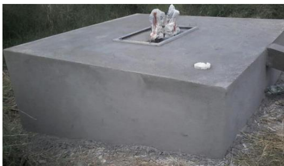
Figura 24: Base de Concreto
