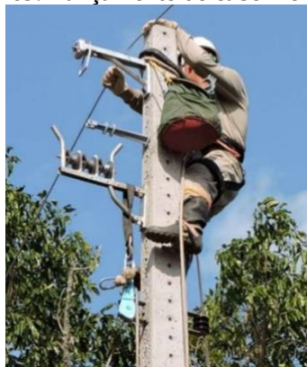
Figura 69: Lançamento do cabo mensageiro
