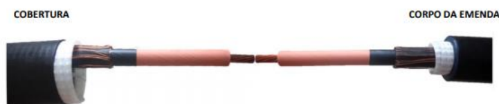
Figura 116: Emenda contrátil a frio
