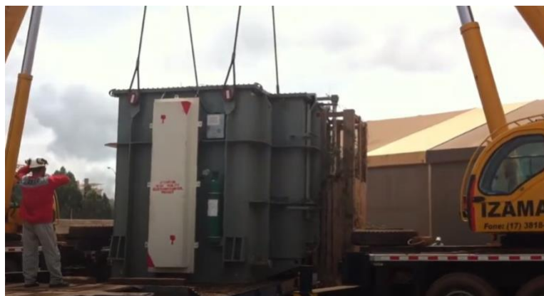
Figura 30: Içamento de transformador de potência
