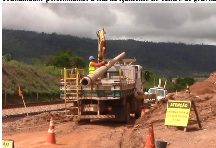
Figura 37: Trabalhador posicionando a fita de içamento no centro de gravidade do poste
