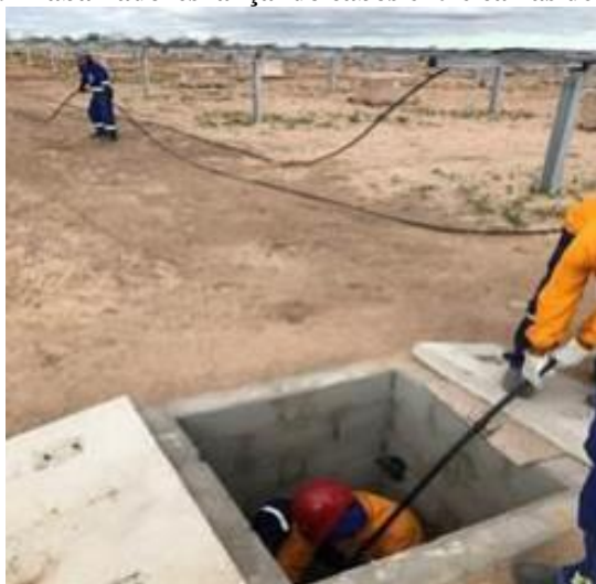
Figura 1: Trabalhadores lançando cabos entre caixas de passagem
