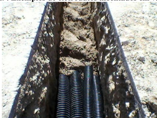
Figura 19: Exemplos de eletrodutos assentados em vala
