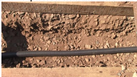
Figura 20: Exemplos de eletrodutos assentados em vala 2
