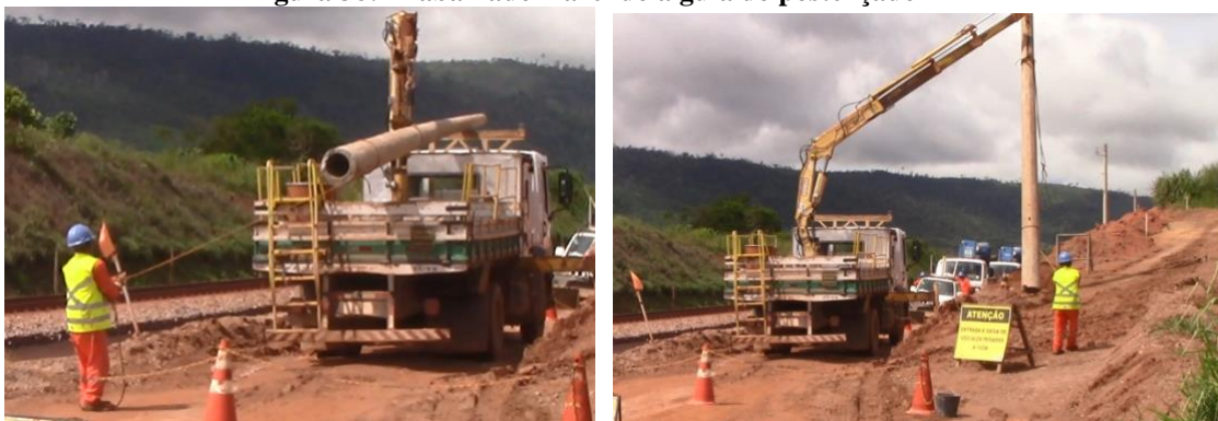
Figura 38: Trabalhador fazendo a guia do poste içado
