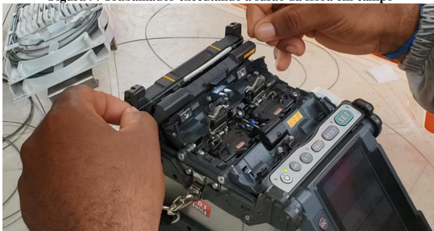
Figura 9: Trabalhador executando a fusão da fibra em campo
