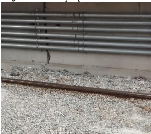
Figura 22: Instalação paralela de eletroduto
