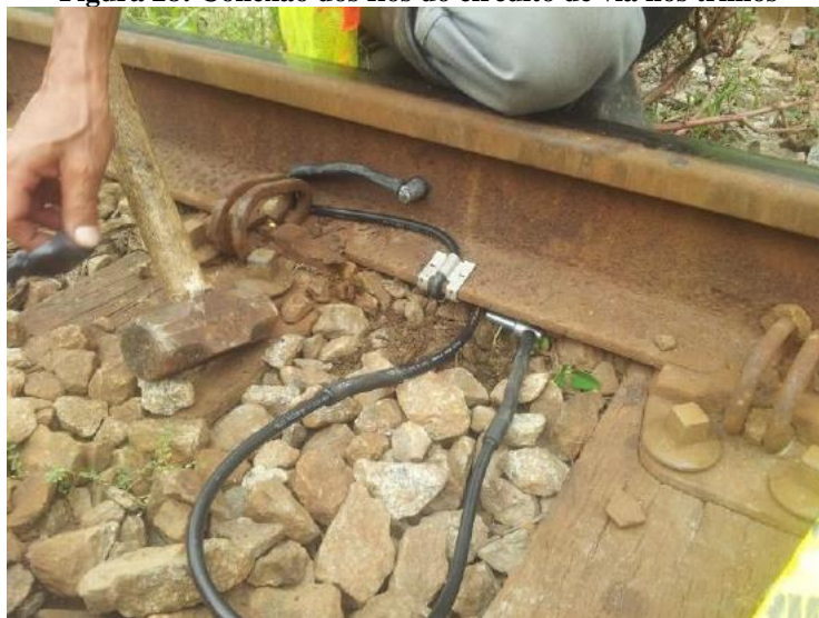
Figura 28: Conexão dos fios do circuito de via nos trilhos
