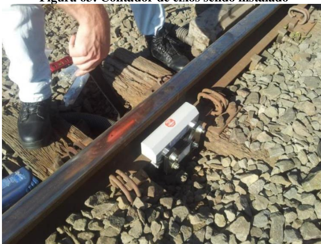
Figura 63: Contador de eixos sendo instalado
