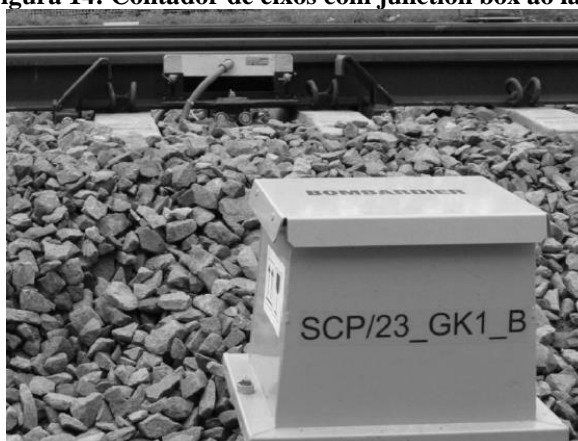
Figura 14: Contador de eixos com junction box ao lado
