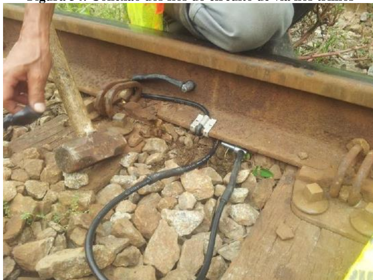
Figura 34: Conexão dos fios do circuito de via nos trilhos
