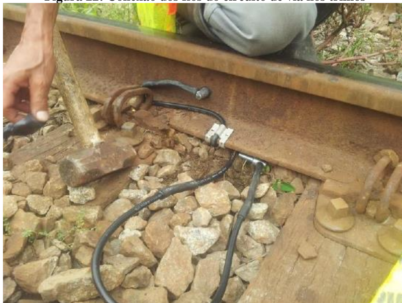
Figura 22: Conexão dos fios do circuito de via nos trilhos
