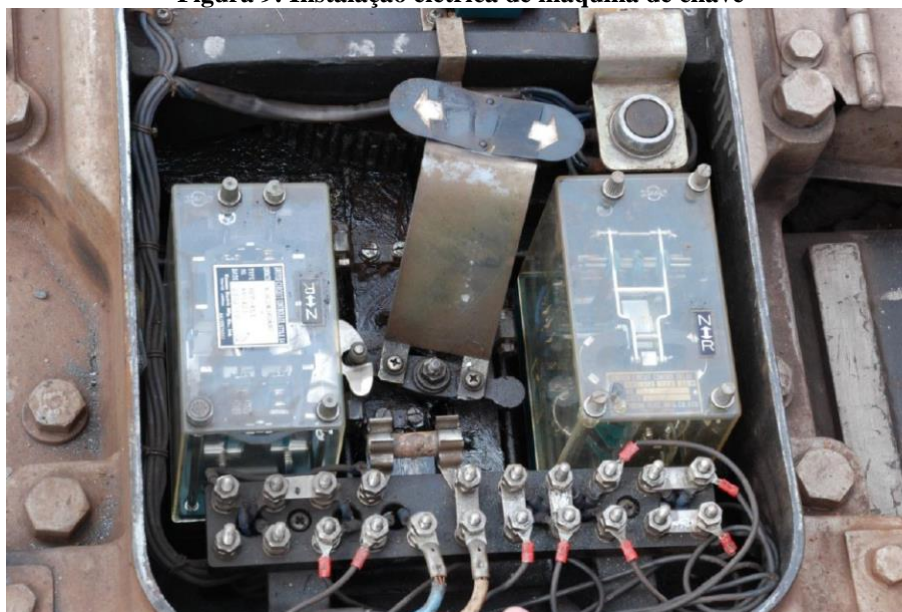
Figura 9: Instalação elétrica de máquina de chave
