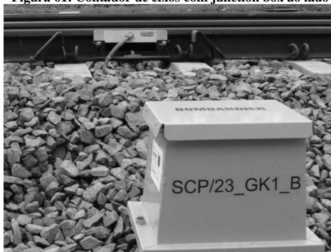
Figura 61: Contador de eixos com junction box ao lado
