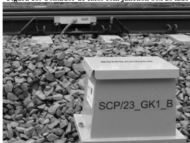
Figura 18: Contador de eixos com junction box ao lado
