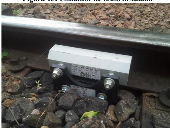
Figura 15: Contador de eixos instalado
