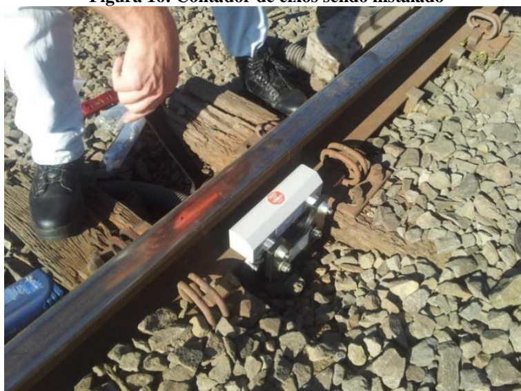
Figura 16: Contador de eixos sendo instalado
