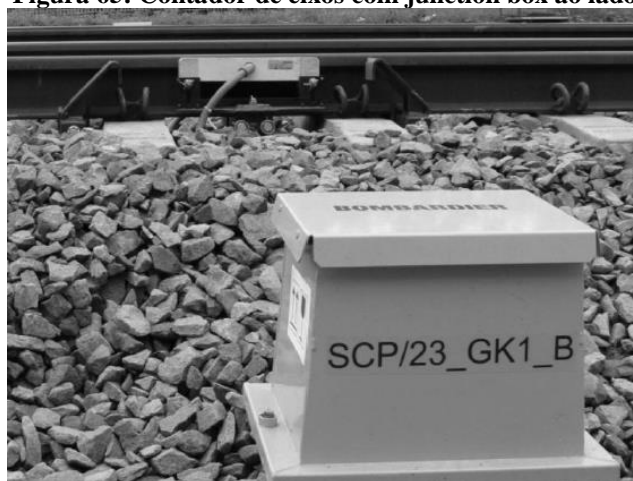
Figura 65: Contador de eixos com junction box ao lado
