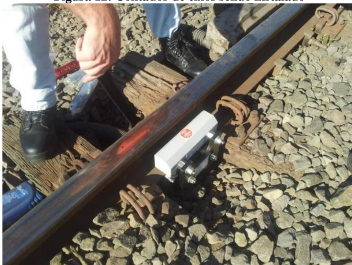
Figura 12: Contador de eixos sendo instalado
