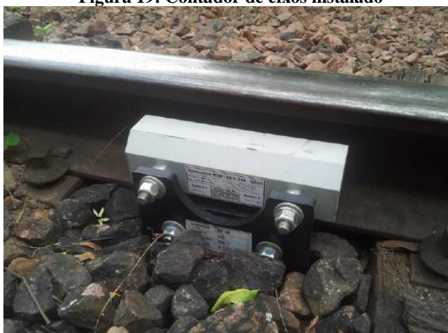
Figura 19: Contador de eixos instalado
