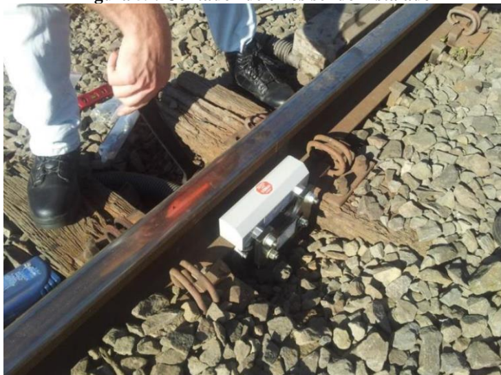
Figura 59: Contador de eixos sendo instalado
