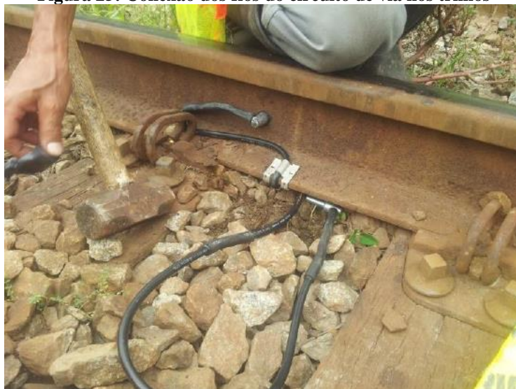
Figura 25: Conexão dos fios do circuito de via nos trilhos
