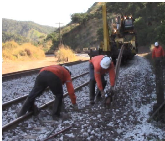
Figura 44: Trabalhadores efetuando a amarração do trilho
