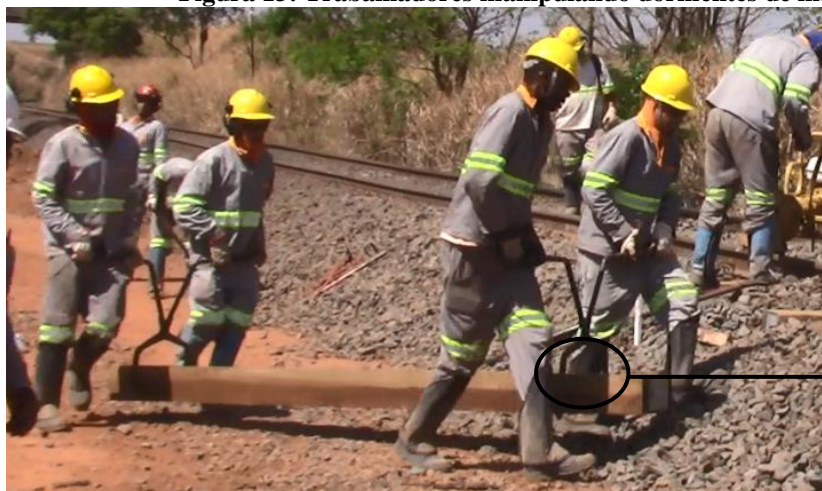
Figura 13: Trabalhadores manipulando dormentes de madeira com tenaz
