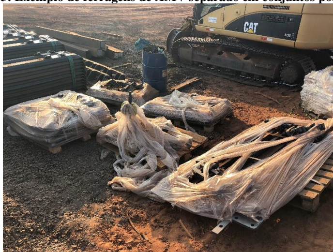
Figura 63: Exemplo de ferragens de AMV separado em conjuntos por palhetes
