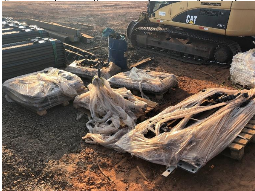
Figura 33: Exemplo de ferragens de AMV separado em conjuntos por palhetes
