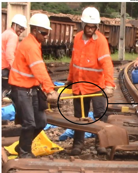
Figura 14: Trabalhadores fazendo o transporte manual de dormente de aço com auxílio de ferramenta manipuladora
