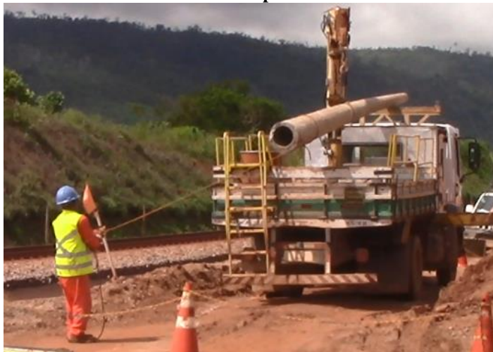
Figura 10: Trabalhador direcionando o poste de concreto durante o içamento
