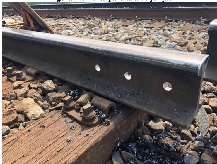
Figura 91: Furos para tala de junção
