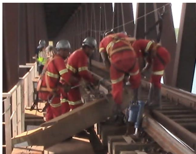
Figura 42: Exemplo de posicionamento de dormente em ponte
