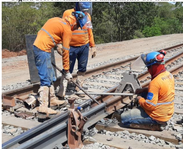
Figura 108: Nivelamento e alinhamento dos trilhos
