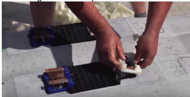
Figura 98: Colocação do isolador lateral
