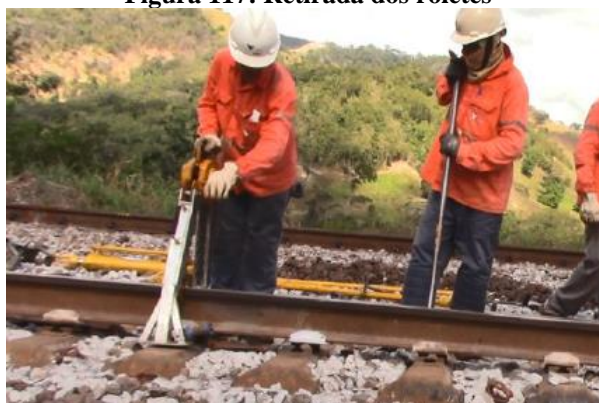
Figura 117: Retirada dos roletes
