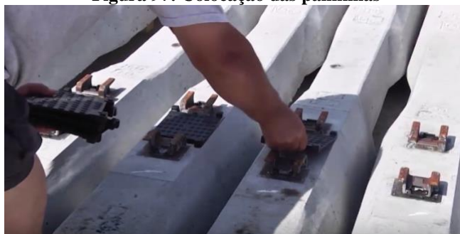
Figura 97: Colocação das palmilhas
