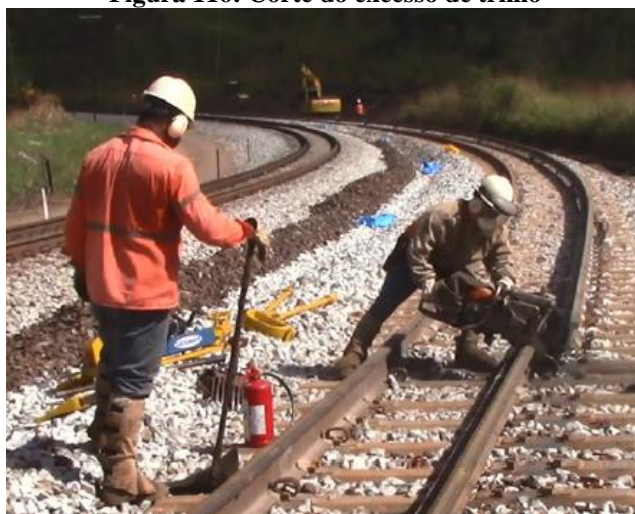
Figura 116: Corte do excesso de trilho
