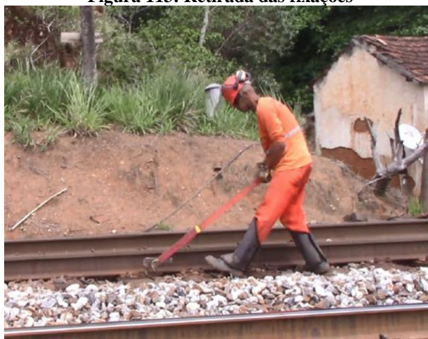
Figura 113: Retirada das fixações
