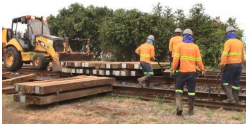
Figura 51: Retroescavadeira distribuindo os dormentes sobre a via
