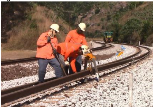
Figura 114: Posicionamento do rolete embaixo do trilho
