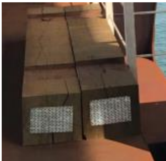
Figura 40: Dormentes para pontes com entalhes
