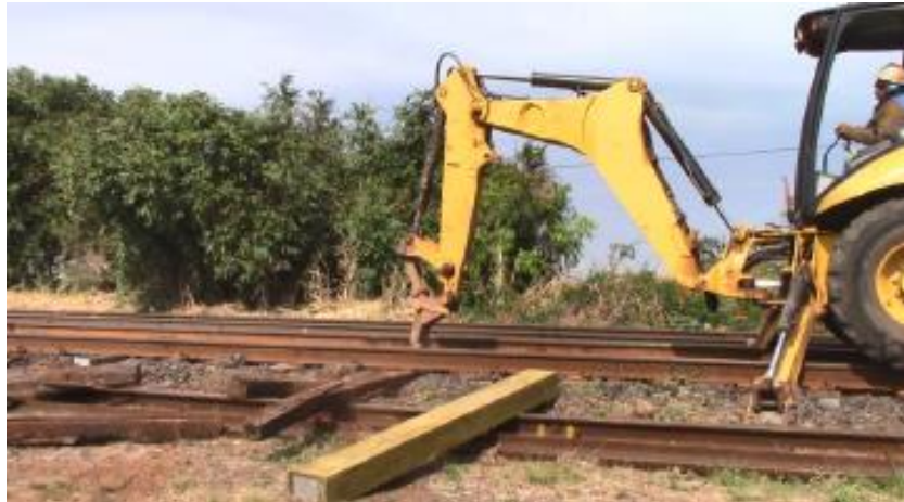
Figura 52: Retroescavadeira retirando os dormentes velhos
