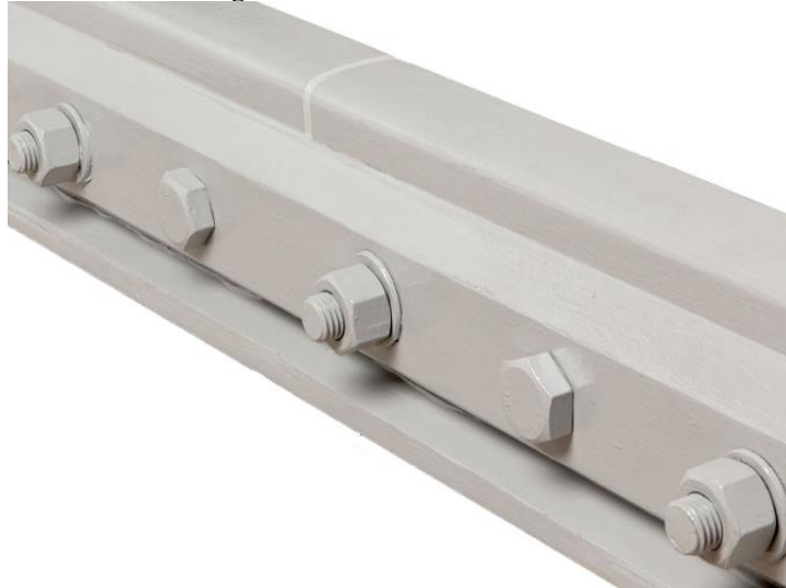
Figura 71: Junta isolada colada
