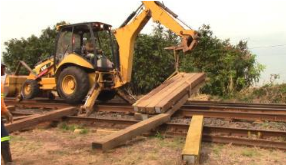
Figura 50: Retroescavadeira distribuindo os dormentes sobre a via
