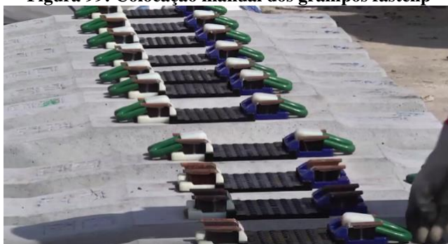
Figura 99: Colocação manual dos grampos fastclip
