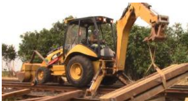
Figura 54: Retroescavadeira com trole ferroviário
