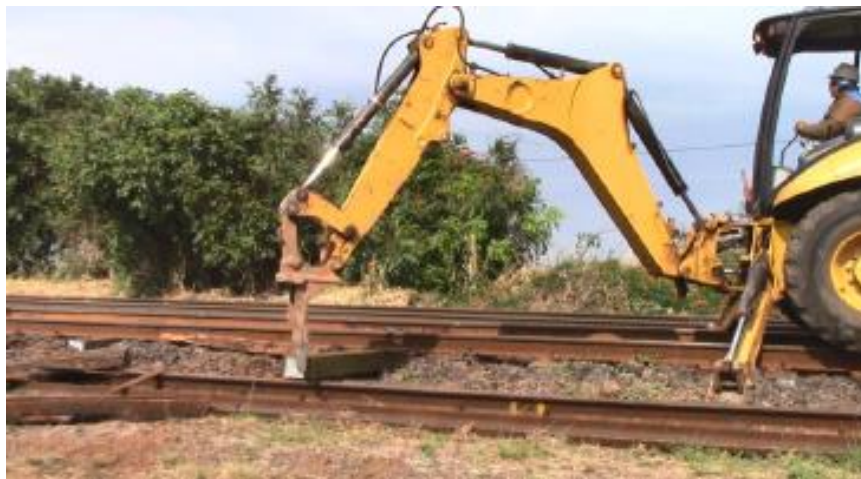
Figura 53: Retroescavadeira posicionando o novo dormente
