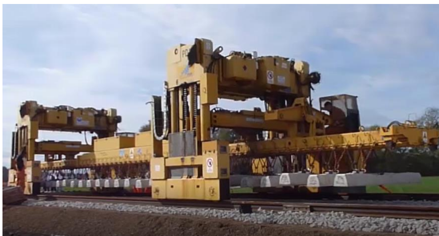
Figura 35: Pórtico duplo de descarga e posicionamento de dormente
