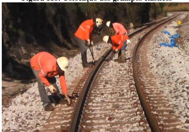
Figura 118: Colocação dos grampos elásticos
