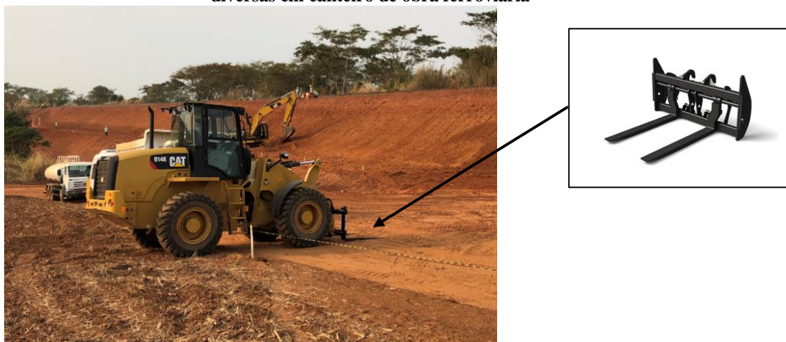
Figura 102: Carregadeira de pneus com uso de implemento de garfo para o transporte de paletes e cargas diversas em canteiro de obra ferroviária
