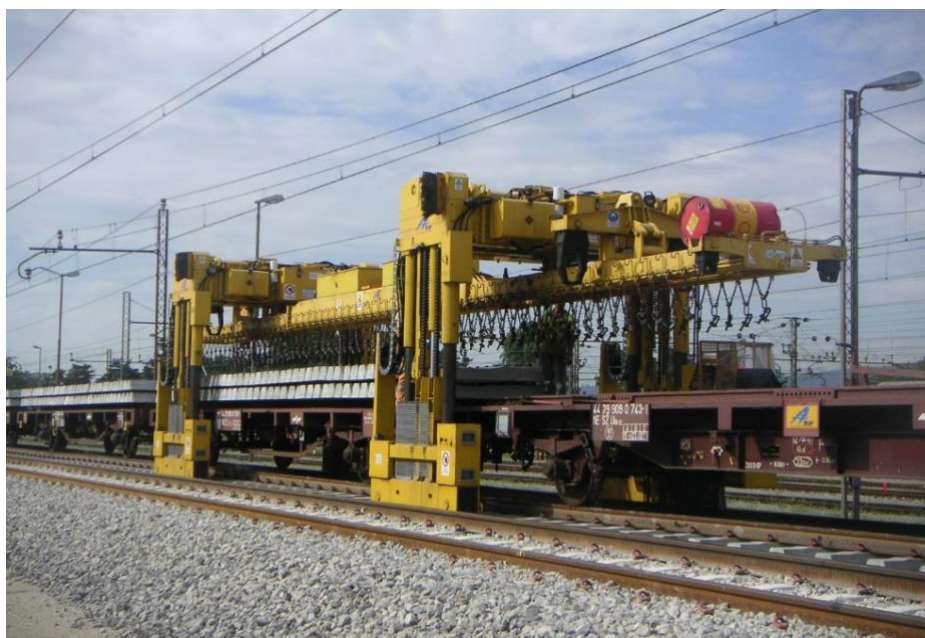
Figura 34: Execução do serviço de posicionamento de dormentes com pórtico
