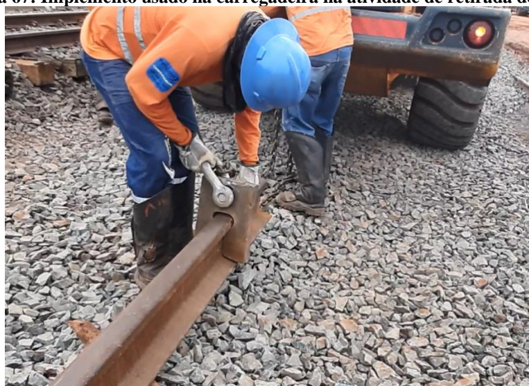
Figura 67: Implemento usado na carregadeira na atividade de retirada do trilho
