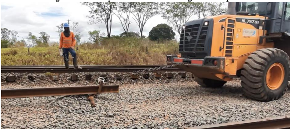
Figura 61: Remoção de trilho com carregadeira de pneus
