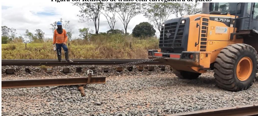
Figura 66: Remoção de trilho com carregadeira de pneus
