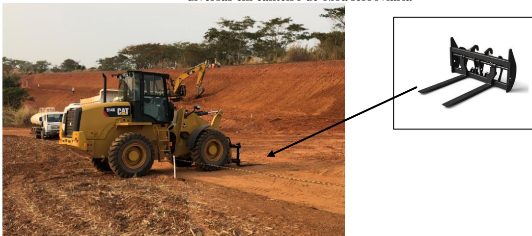
Figura 59: Carregadeira de pneus com uso de implemento de garfo para o transporte de paletes e cargas diversas em canteiro de obra ferroviária
