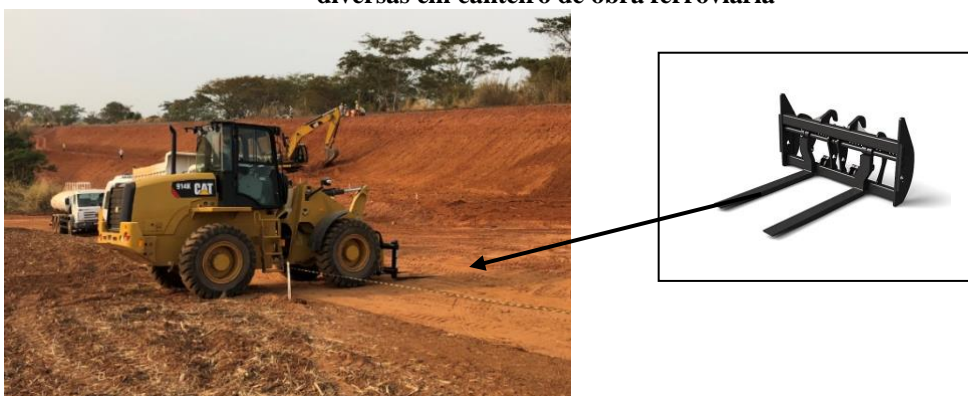
Figura 64: Carregadeira de pneus com uso de implemento de garfo para o transporte de paletes e cargas diversas em canteiro de obra ferroviária
