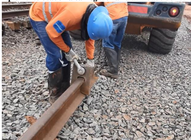
Figura 62: Implemento usado na carregadeira na atividade de retirada do trilho
