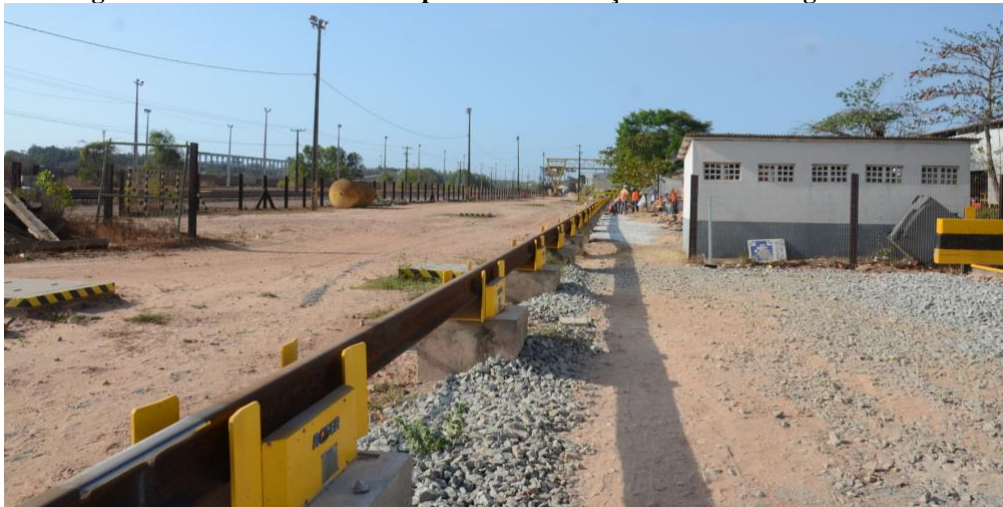
Figura 22: Caminho de roletes para movimentação de trilhos longos soldados
