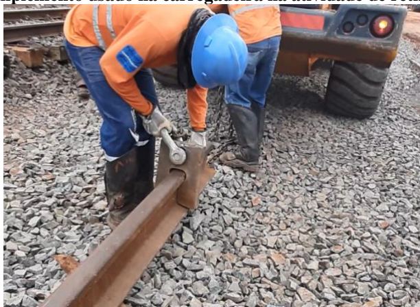
Figura 57: Implemento usado na carregadeira na atividade de retirada do trilho
