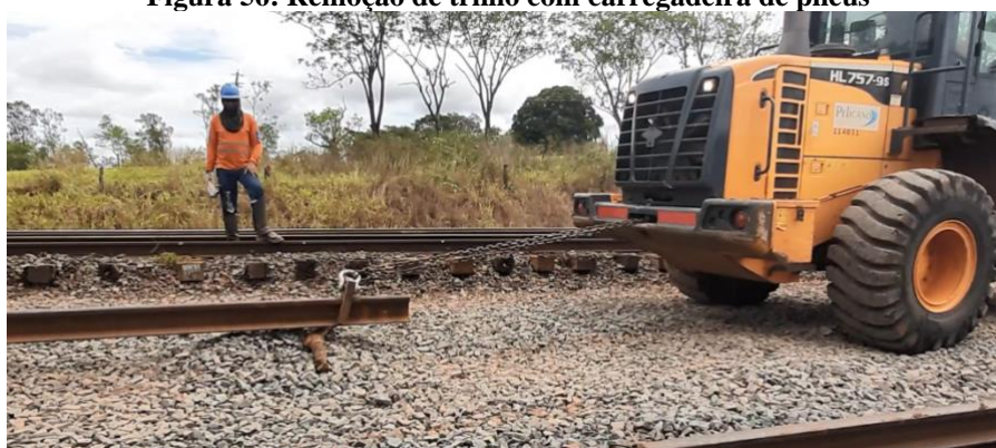
Figura 56: Remoção de trilho com carregadeira de pneus
