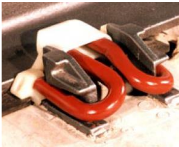
Figura 221: Exemplo de isolador para fixação lateral
