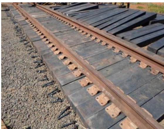
Figura 163: Exemplo de dormente de plástico
