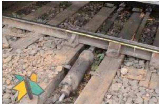
Figura 27: Exemplo de aparelho de manobra manual talonável
