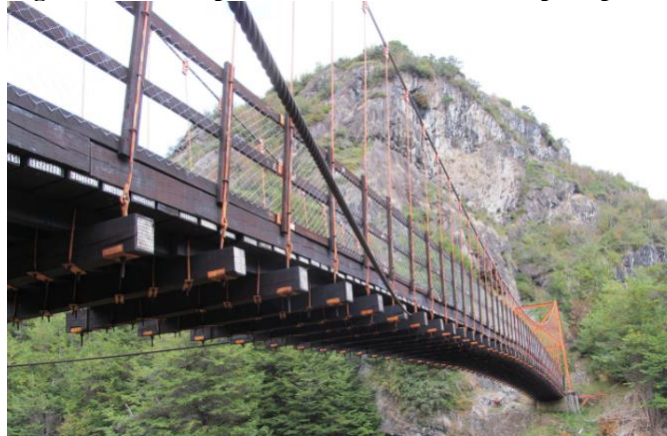
Figura 164: Exemplo de dormente de madeira para pontes
