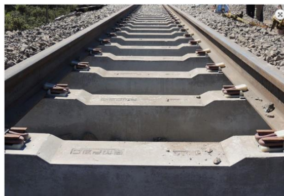
Figura 228: Exemplo de jogo de dormentes de concreto para AMV
