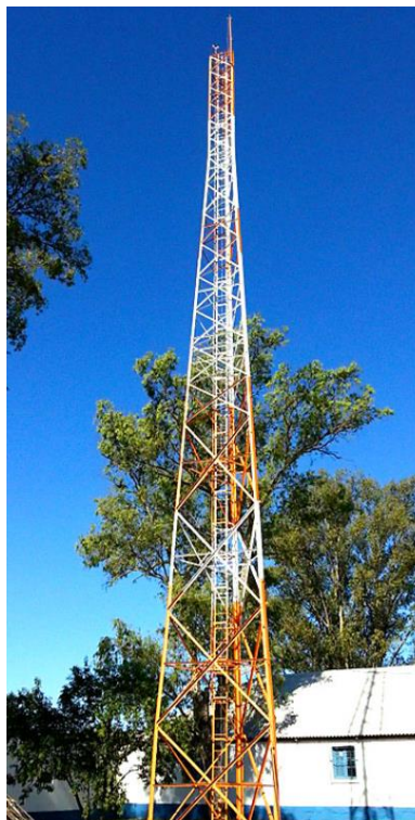
Figura 412: Exemplo de torre autoportante
