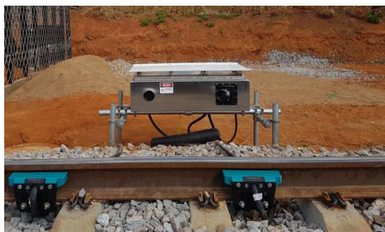
Figura 151: Exemplo de detector de truque
