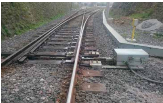
Figura 126: Exemplo de conjunto de ferragens para máquina de chave MD-2000
