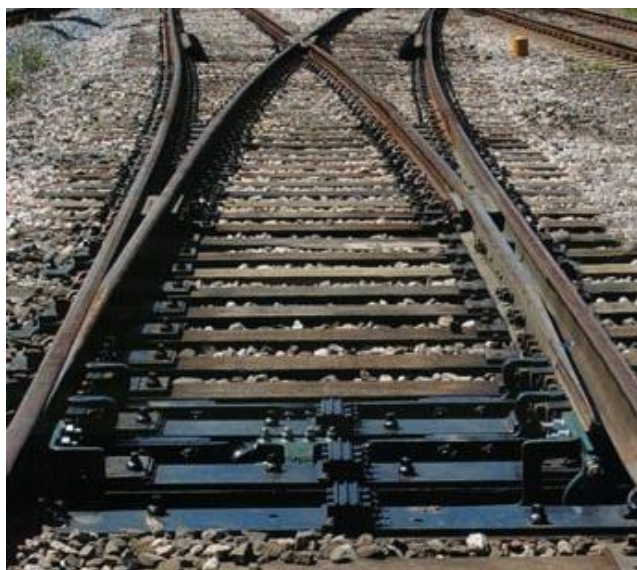
Figura 28: Exemplo de aparelho de mudança de via
