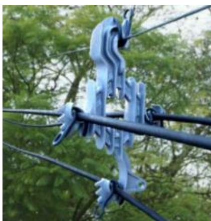
Figura 181: Exemplo de espaçador polimérico losangular
