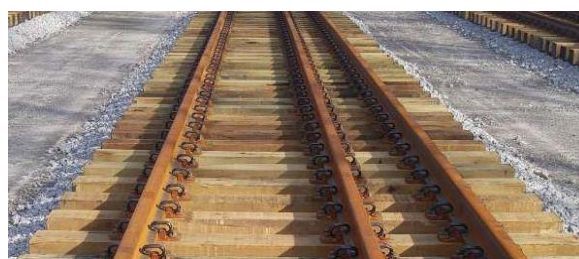
Figura 162: Exemplo de dormente de madeira
