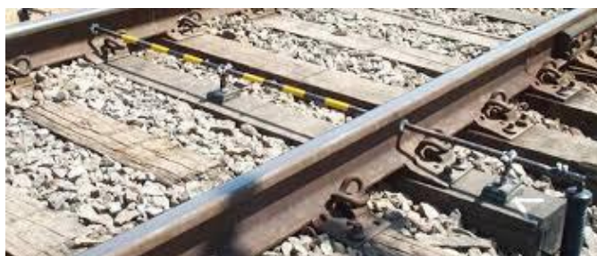
Figura 60 – Detector de descarrilamento de campo
