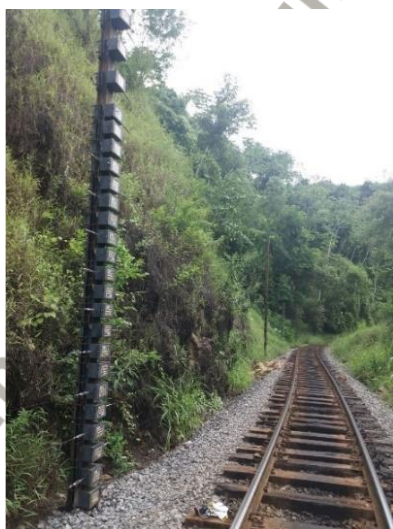
Figura 61 – Detector de queda de barreira
