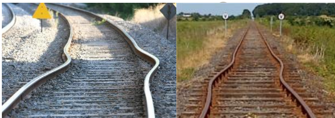
Figura 37 – Flambagens de linha em curvas “C” e tangente “S”.
