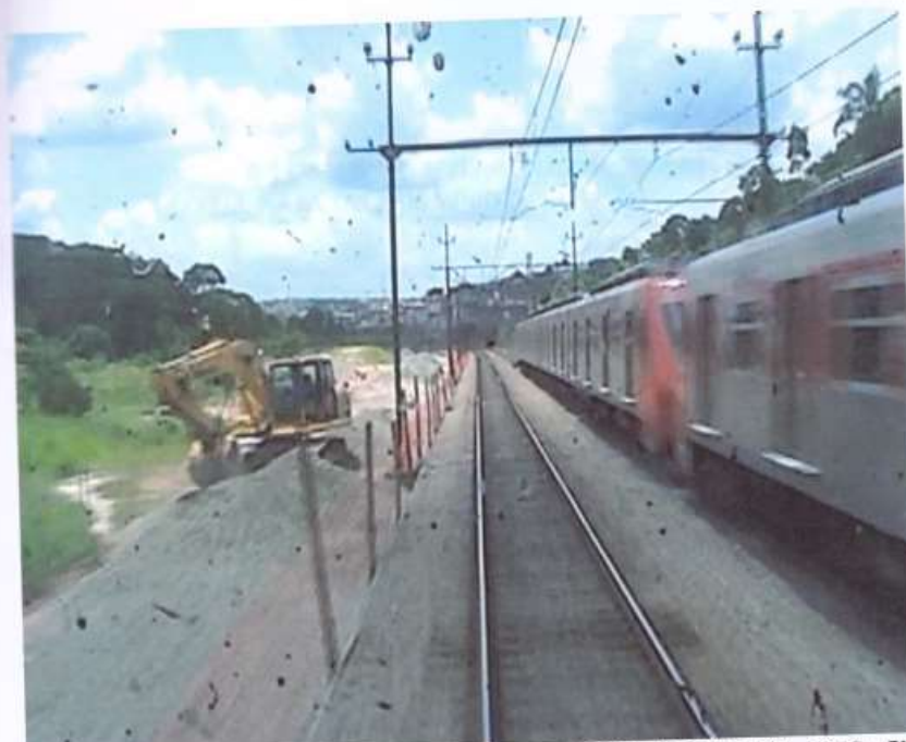
FOTO 1: DESTAQUE DE OBRAS DE TERRAPLENAGEM, NO (LE) DA FOTO, EM EXECUÇÃO PELA CPTM, NA FAIXA DE DOMÍNIO DA MRS.
