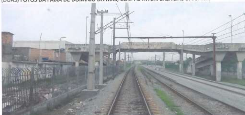
FOTO 1: DESTAQUE NO (LE) DA PASSARELA E ESTRUTURAS DE SUSTENTAÇÃO DA REDE AÉREA DE TRACÇÃO, CONSTRUÍDAS PELA CPTM, NA FAIXA DE DOMÍNIO DA MRS.
