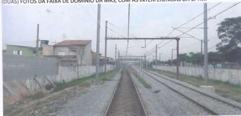
FOTO 1: DESTAQUE NO (LE) DE ESTRUTURAS PARA SUSTENTAÇÃO DA REDE AÉREA DE TRACÇÃO DA CPTM, INSTALADAS NA FAIXA DE DOMÍNIO DA MRS.
