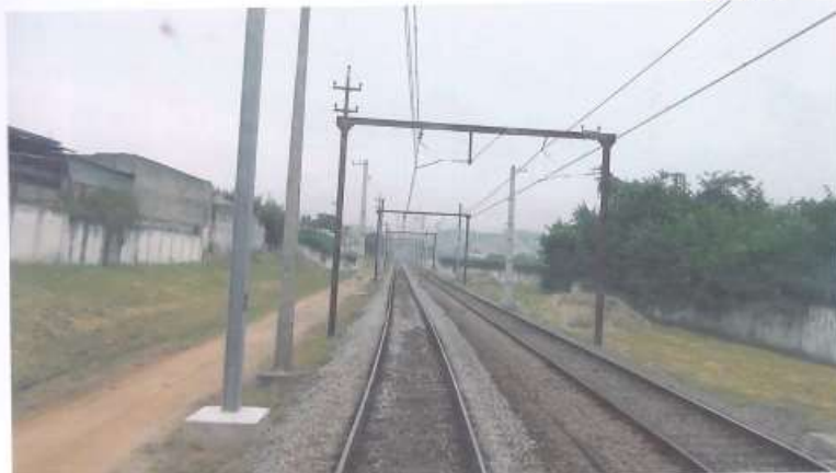
FOTO 1: DESTAQUE NO (LE) DE ESTRUTURAS DE SUSTENTAÇÃO DA REDE AÉREA DE TRACÇÃO, INSTALADAS PELA CPTM, NA FAIXA DE DOMÍNIO DA MRS.
