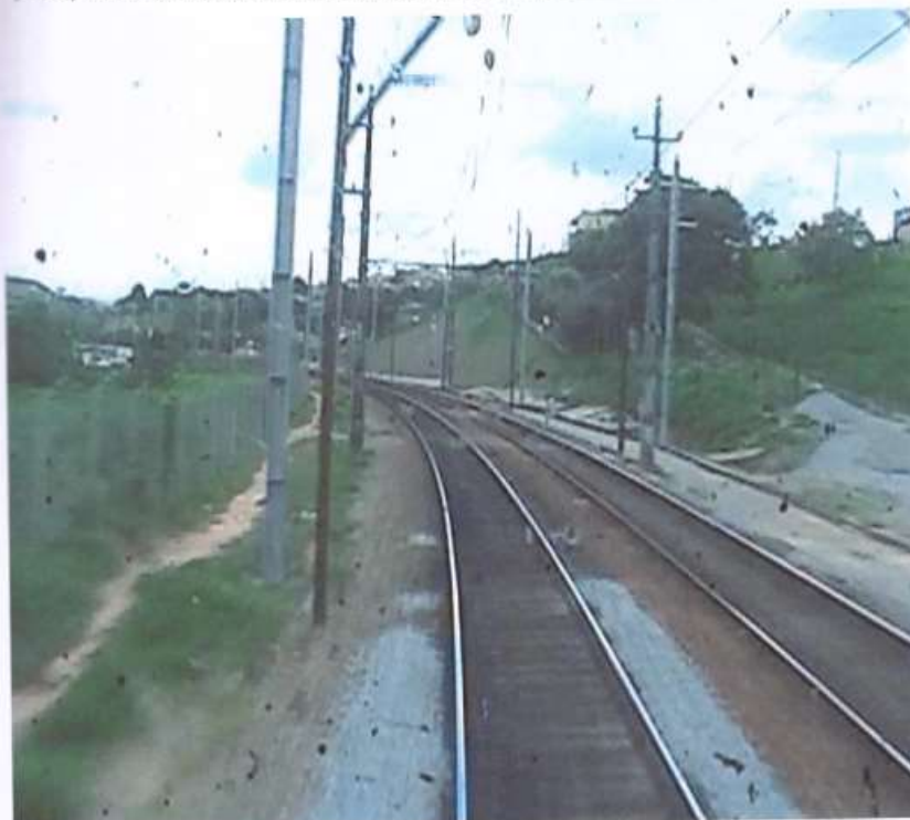
FOTO 1: DESTAQUE DE ESTRUTURAS METÁLICAS DE REDE AÉREA, NO (LE) DA FOTO, INSTALADAS PELA CPTM, NA FAIXA DE DOMÍNIO DA MRS.
