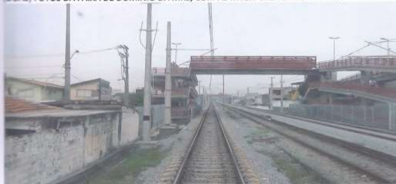
FOTO 1: DESTAQUE NO (LE), DA PASSARELA E ESTRUTURAS PARA SUSTENTAÇÃO DA REDE AÉREA DE TRACÇÃO, CONSTRUÍDAS PELA CPTM, NA FAIXA DE DOMÍNIO DA MRS.
