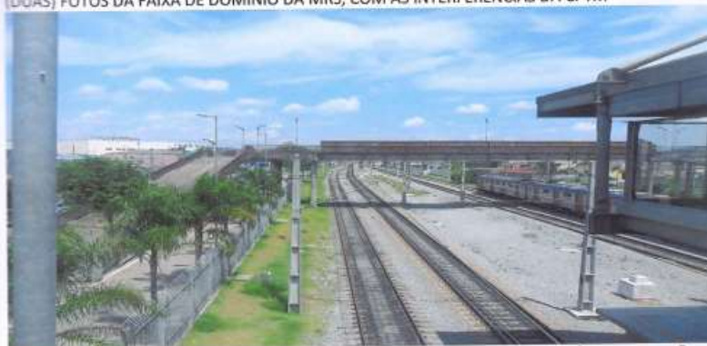
FOTO 1: DESTAQUE NO (LE) DE ESTRUTURAS PARA SUSTENTAÇÃO DA REDE AÉREA DE TRACÇÃO DA CPTM, INSTALADAS NA FAIXA DE DOMÍNIO DA MRS.
