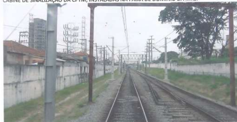
FOTO 2: DESTAQUE NO (LE) DE ESTRUTURAS PARA SUSTENTAÇÃO DA REDE AÉREA DE TRACÇÃO DA CPTM, INSTALADAS NA FAIXA DE DOMÍNIO DA MRS.
