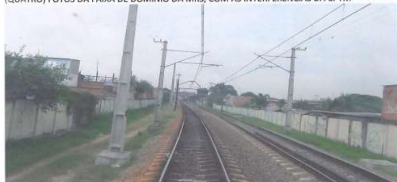
FOTO 1: DESTAQUE NO (LE) DE ESTRUTURAS PARA SUSTENTAÇÃO DA REDE AÉREA DE TRACÇÃO DA CPTM, INSTALADAS NA FAIXA DE DOMÍNIO DA MRS.
