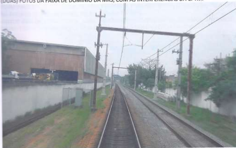
FOTO 1: DESTAQUE NO (LE), DE ESTRUTURAS PARA SUSTENTAÇÃO DA REDE AÉREA DE TRACÇÃO E CABINE DE SINALIZAÇÃO DA CPTM, INSTALADAS NA FAIXA DE DOMÍNIO DA MRS.
