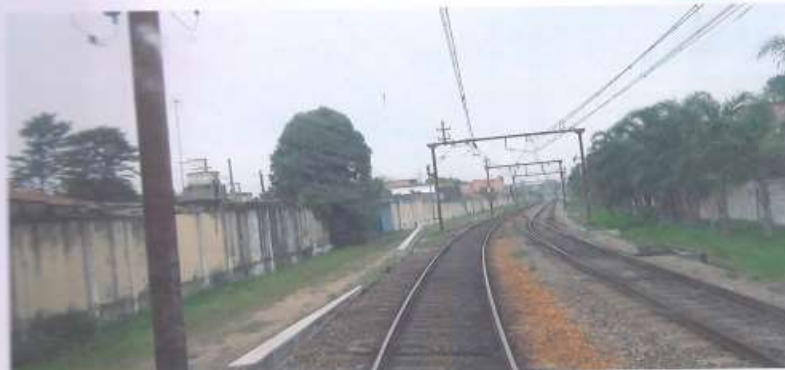
FOTO 4: DESTAQUE NO (LE) DE ESTRUTURAS PARA SUSTENTAÇÃO DA REDE AÉREA DE TRACÇÃO DA CPTM, PARA SEREM INSTALADAS, NA FAIXA DE DOMÍNIO DA MRS.
