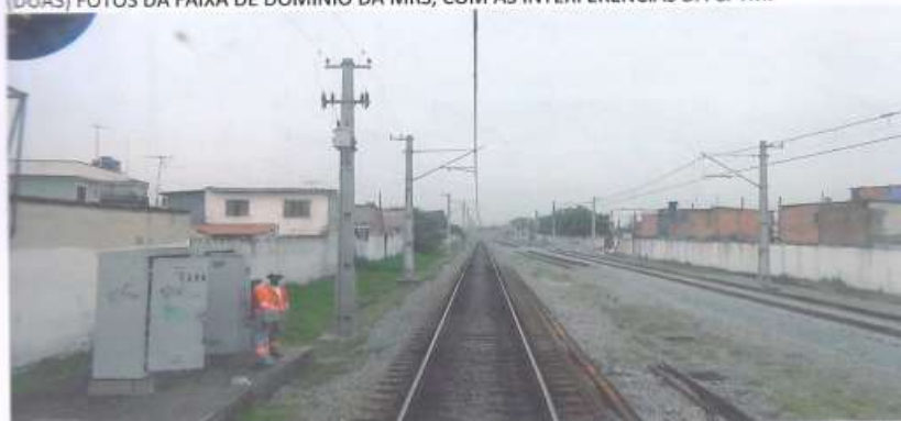
FOTO 1: DESTAQUE NO (LE), DE ESTRUTURAS PARA SUSTENTAÇÃO DA REDE AÉREA DE TRACÇÃO E CABINE DE SINALIZAÇÃO DA CPTM, INSTALADAS NA FAIXA DE DOMÍNIO DA MRS.
