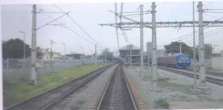
FOTO 2: DESTAQUE NO (LE) DE ESTRUTURAS PARA SUSTENTAÇÃO DA REDE AÉREA DE TRACÇÃO DA CPTM, INSTALADAS NA FAIXA DE DOMÍNIO DA MRS.
