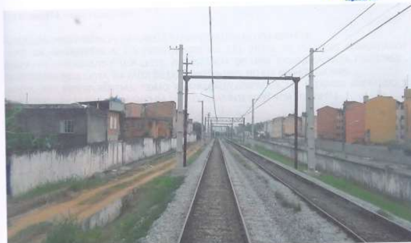
FOTO 3: DESTAQUE NO (LE), DE ESTRUTURAS DE SUSTENTAÇÃO DA REDE AÉREA DE TRACÇÃO, INSTALADAS PELA CPTM, NA FAIXA DE DOMÍNIO DA MRS
