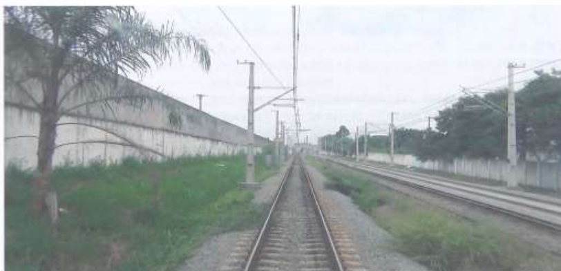
FOTO 2: DESTAQUE NO (LE) DE ESTRUTURAS PARA SUSTENTAÇÃO DA REDE AÉREA DE TRACÇÃO DA CPTM, INSTALADAS NA FAIXA DE DOMÍNIO DA MRS.
