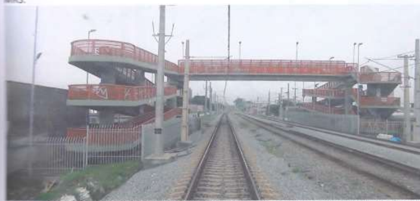
FOTO 2: DESTAQUE NO (LE), DA PASSARELA E ESTRUTURAS DE SUSTENTAÇÃO DA REDE AÉREA DE TRACÇÃO, CONSTRUÍDAS PELA CPTM, NA FAIXA DE DOMÍNIO DA MRS.
