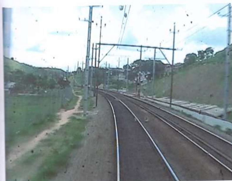
FOTO 2: DESTAQUE DE ESTRUTURAS METÁLICAS DE REDE AÉREA, NO (LE) DA FOTO, INSTALADAS PELA CPTM, NA FAIXA DE DOMÍNIO DA MRS.
