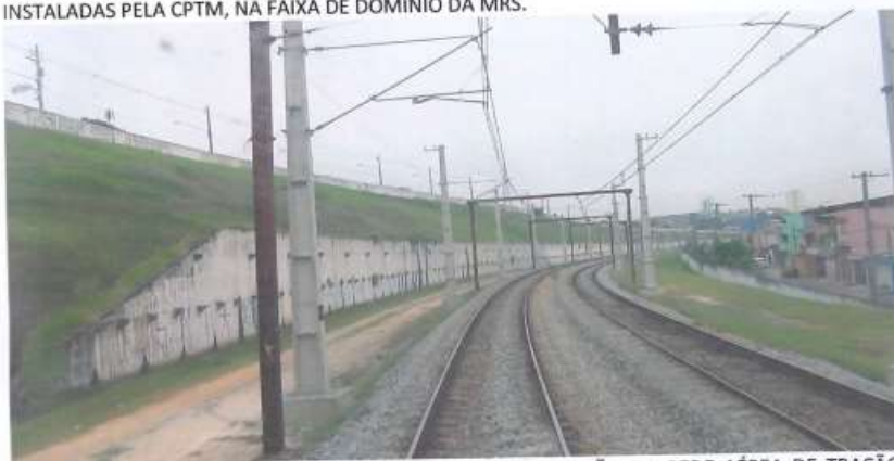
FOTO 2: DESTAQUE NO (LE), DE ESTRUTURAS DE SUSTENTAÇÃO DA REDE AÉREA DE TRACÇÃO, INSTALADAS PELA CPTM, NA FAIXA DE DOMÍNIO DA MRS.
