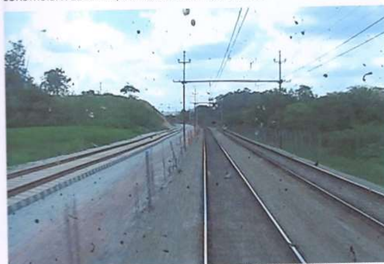
FOTO 2: DESTAQUE DE PLATAFORMA JÁ COM LINHA FERROVIÁRIA, NO (LE) DA FOTO, CONSTRUÍDA PELA CPTM, NA FAIXA DE DOMÍNIO DA MRS.
