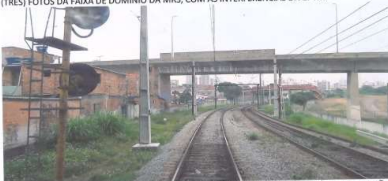
FOTO 1: DESTAQUE NO (LE) DE ESTRUTURAS DE SUSTENTAÇÃO DA REDE AÉREA DE TRACÇÃO, INSTALADAS PELA CPTM, NA FAIXA DE DOMÍNIO DA MRS.
