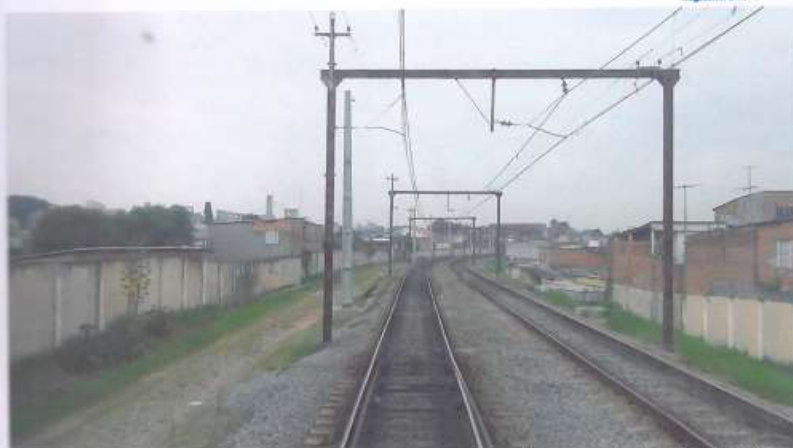
FOTO 2: DESTAQUE NO (LE) DE ESTRUTURAS PARA SUSTENTAÇÃO DA REDE AÉREA DE TRACÇÃO DA CPTM, INSTALADAS NA FAIXA DE DOMÍNIO DA MRS.
