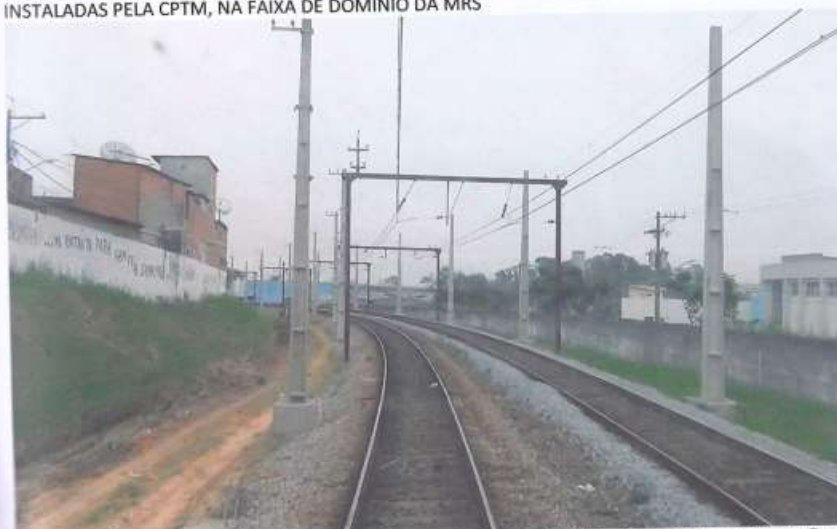
FOTO 4: DESTAQUE NO (LE), DE ESTRUTURAS DE SUSTENTAÇÃO DA REDE AÉREA DE TRACÇÃO, INSTALADAS PELA CPTM, NA FAIXA DE DOMÍNIO DA MRS
