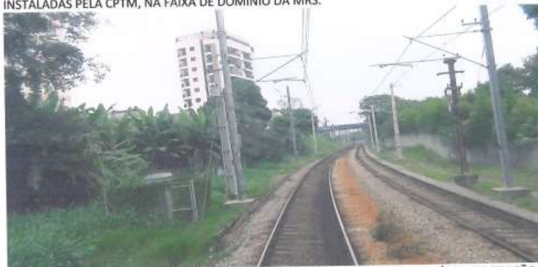
FOTO 2: DESTAQUE NO (LE) DE ESTRUTURAS DE SUSTENTAÇÃO DA REDE AÉREA DE TRACÇÃO, E CABINE DE SINALIZAÇÃO, INSTALADAS PELA CPTM, NA FAIXA DE DOMÍNIO DA MRS.
