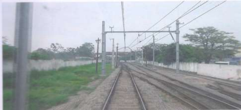
FOTO 2: DESTAQUE NO (LE), DE ESTRUTURAS DE SUSTENTAÇÃO DA REDE AÉREA DE TRACÇÃO DA CPTM, INSTALADAS NA FAIXA DE DOMÍNIO DA MRS.
