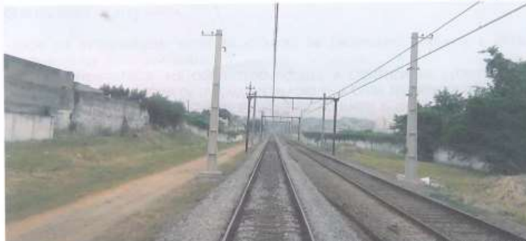
FOTO 3: DESTAQUE NO (LE) DE ESTRUTURAS DE SUSTENTAÇÃO DA REDE AÉREA DE TRACÇÃO, INSTALADAS PELA CPTM, NA FAIXA DE DOMÍNIO DA MRS.
