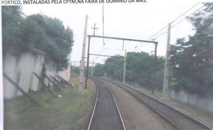
FOTO 2: DESTAQUE NO (LE) DE ESTRUTURAS DE SUSTENTAÇÃO DA REDE AÉREA DE TRAÇÃO, INSTALADAS PELA CPTM, NA FAIXA DE DOMÍNIO DA MRS.
