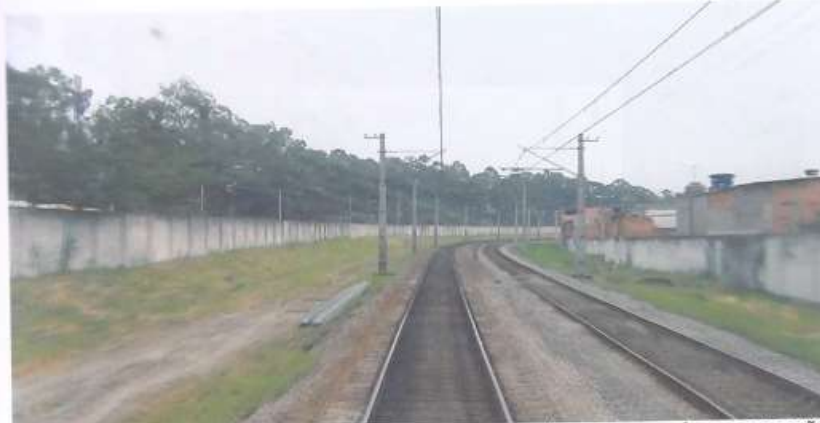
FOTO 3: DESTAQUE NO (LE) DE ESTRUTURAS DE SUSTENTAÇÃO DA REDE AÉREA DE TRACÇÃO, INSTALADAS PELA CPTM, NA FAIXA DE DOMÍNIO DA MRS.
