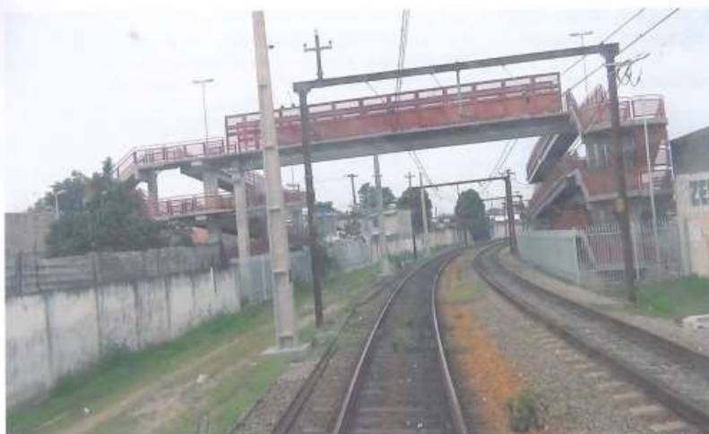
FOTO 3: DESTAQUE NO (LE) DE ESTRUTURAS PARA SUSTENTAÇÃO DA REDE AÉREA DE TRACÇÃO DA CPTM, INSTALADAS NA FAIXA DE DOMÍNIO DA MRS.
