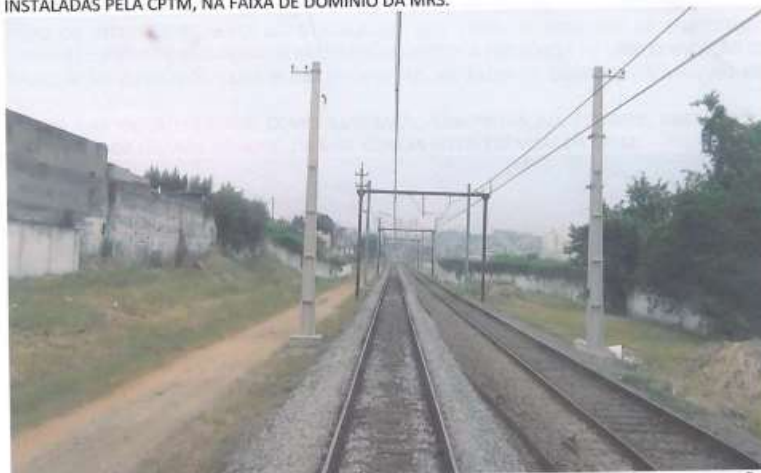
FOTO 2: DESTAQUE NO (LE) DE ESTRUTURAS DE SUSTENTAÇÃO DA REDE AÉREA DE TRACÇÃO, INSTALADAS PELA CPTM, NA FAIXA DE DOMÍNIO DA MRS.
