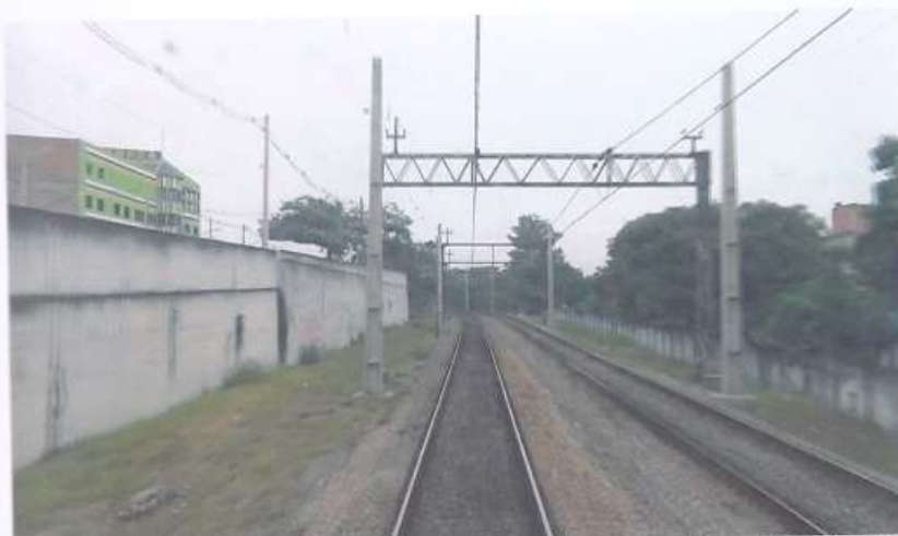
FOTO 1: DESTAQUE NO (LE) DE ESTRUTURAS DE SUSTENTAÇÃO DA REDE AÉREA DE TRAÇÃO, COM PÓRTICO, INSTALADAS PELA CPTM, NA FAIXA DE DOMÍNIO DA MRS.
