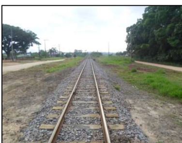
Km 89 – Substituição de dormentes
