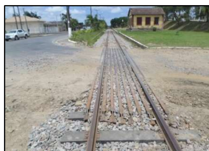
Km 13+400 – Substituição de dormentes e contratrilhos
