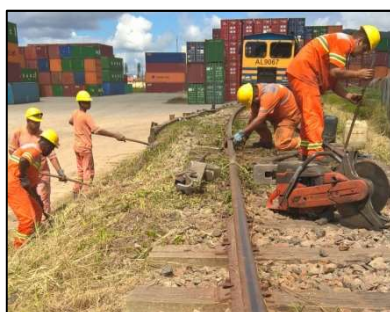
Linha elevado – Substituição de dormentes e trilhos
