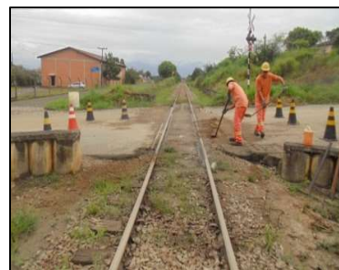
Km 13+600 – Substituição de dormentes e contratrilhos
