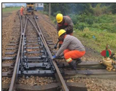
AMV 08 – Substituição de dormentes e ferragens de AMV
