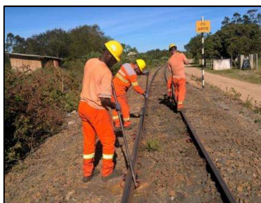
Km 33 – Manutenção de fixação Fist
