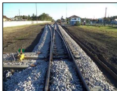
AMV 01 – Substituição de dormentes e ferragem de AMV
