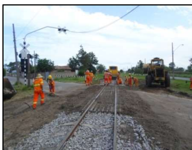
Km 49+060 – Substituição de dormentes e contratrilhos
