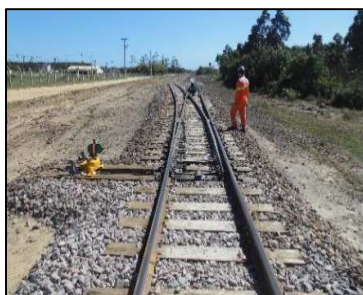
AMV 01 Retiro – Substituição de dormentes e ferragens de AMV
