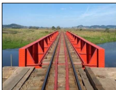
Km 57+762 – Substituição de dormentes e recuperação na estrutura
