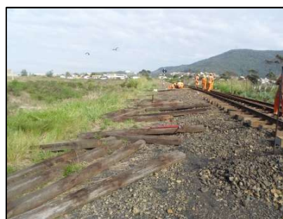
Linha Cais – Substituição de dormentes
