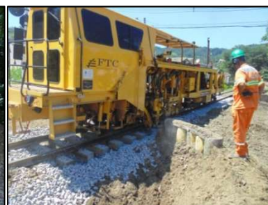
Km 13 – Nivelamento mecanizado
