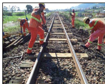
Km 77 – Substituição de dormentes e revisão da fixação
