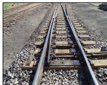
AMV 02 – Substituição de dormentes de AMV
