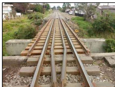
Km 01+299 – Substituição de dormentes e contratrilhos
