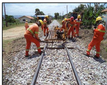
Km 57+520 – Substituição de dormentes e contratrilhos
