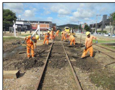
Km 24 – Substituição de dormentes e limpeza de lastro
