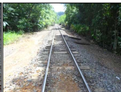
Km 11 – Substituição de dormentes e revisão de fixação
