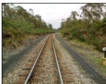
Km 100 – Substituição de dormentes e revisão de fixações
