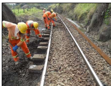
Km 57 – Substituição de trilhos TR 45
