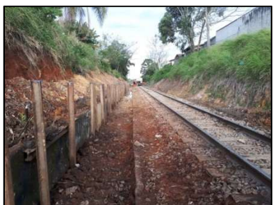
Km 01 – Construção de contenção e limpeza
