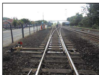
AMV 22 – Substituição de dormentes de AMV
