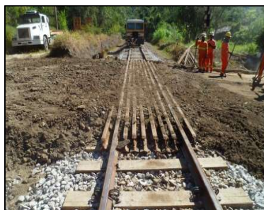
Km 09+365 – Substituição de dormentes e contratrilhos
