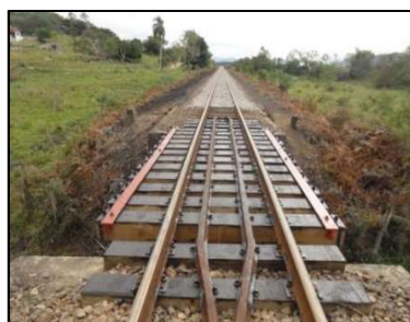
Km 61+900 – Substituição de dormentes e contratrilhos
