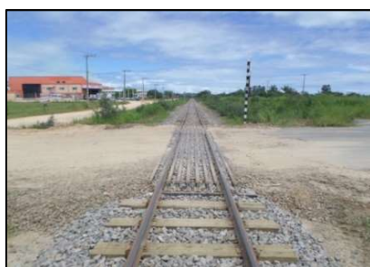
Km 03+424 – Substituição de dormentes e contratrilhos
