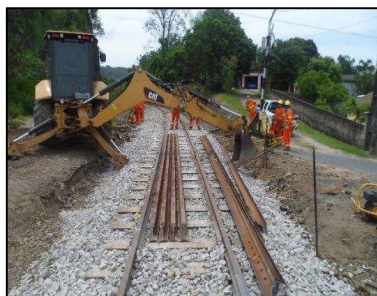
Km 05+788 – Substituição de dormentes e contratrilhos
