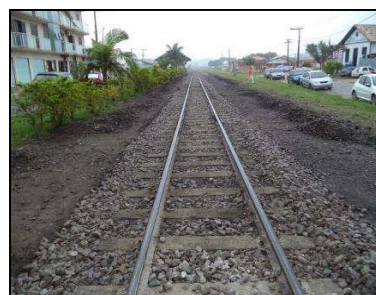
Km 66 – Substituição de dormentes e limpeza de lastro
