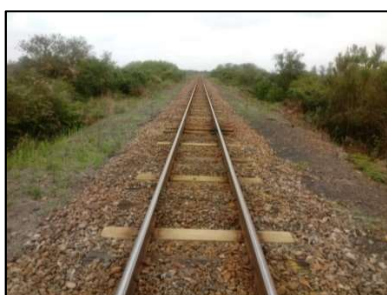
Km 87 – Substituição de dormentes e revisão de fixações
