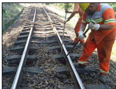
Km 31 – Manutenção de fixação Fist
