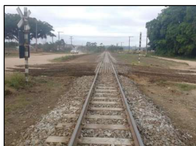
Km 90+100 – Substituição de dormentes e contratrilhos
