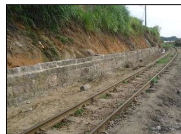
Km 33 – Construção de contenção
