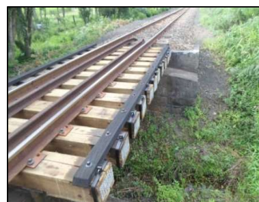
Km 62+535 – Substituição de dormentes
