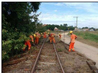
Triângulo MEX – Substituição de dormentes
