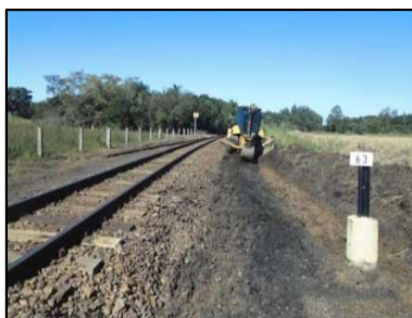
Km 63 – Regularização da plataforma
