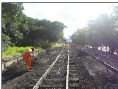
L 03 – Substituição de dormentes
