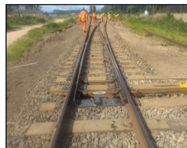
AMV 02 Retiro – Substituição de dormentes e ferragens de AMV
