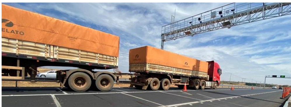
Figura 3 - Primeiro sistema de pesagem tipo HS-WIM do Ambiente Regulatório Experimental.
