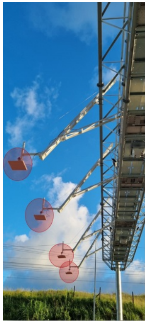
Figura 5: Antenas RFID - Responsáveis pela leitura dos TAG
