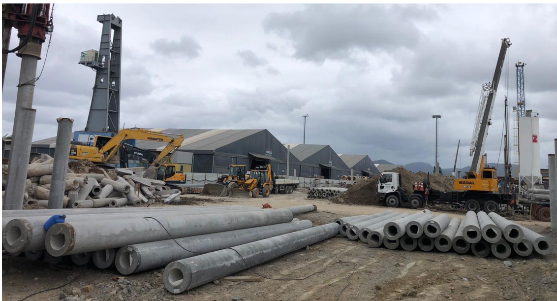
Fotografia 10 – Obras em andamento no terminal arrendado TESC
