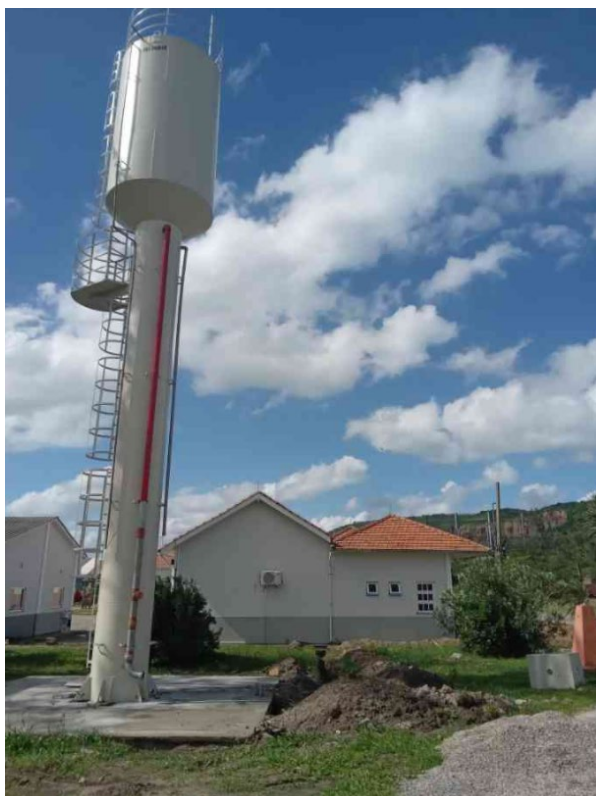
Figura 4.25 – Instalação de uma das torres de reservatório de sistema de combate ao incêndio do porto
