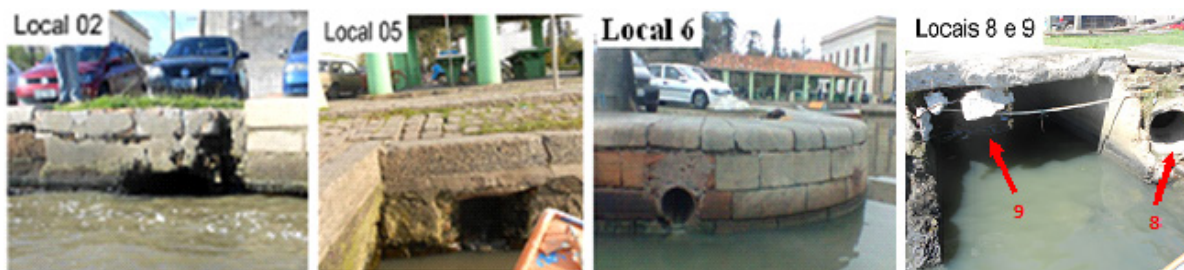
Figura 6 – Porto Velho (Rio Grande - RS): Locais 2, 5, 6 e 9 possuem efluentes pluviais contaminados com provável ligação clandestina de esgoto.
