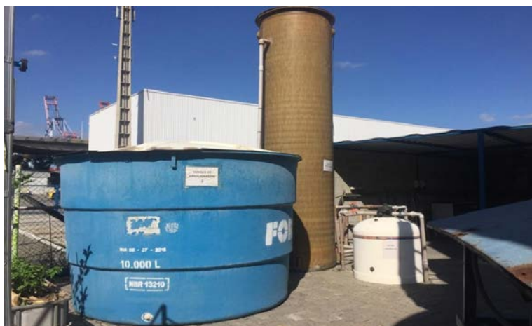
Foto 22 - Cisterna de armazenagem de água de reúso.
