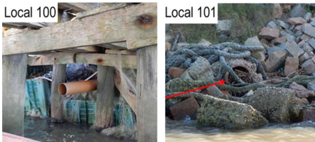
Figura 19 - Superporto (Rio Grande - RS): emissários da Indústria Leal Santos Pescados. Área do Terminal Pesqueiro. No Local 101 escoava um efluente contaminado. No Local 100 o efluente não estava vazando, pois não se estava desembarcando pescados durante a amostragem.
