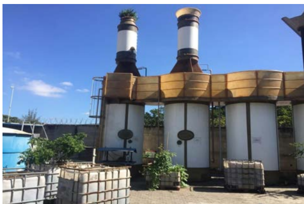
Foto 17 – Torres e tanques de aeração com filtros de carvão ativado.
