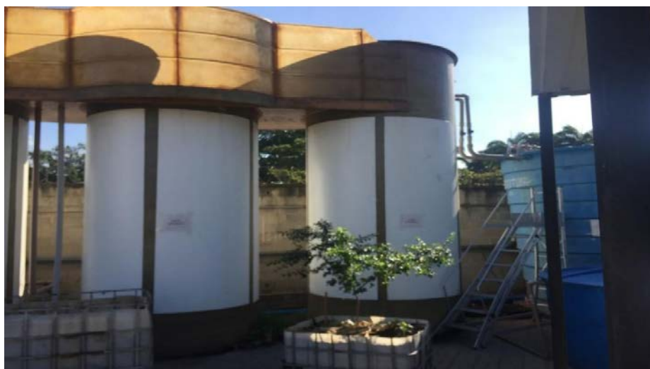
Foto 16 - Tanques anaeróbicos
