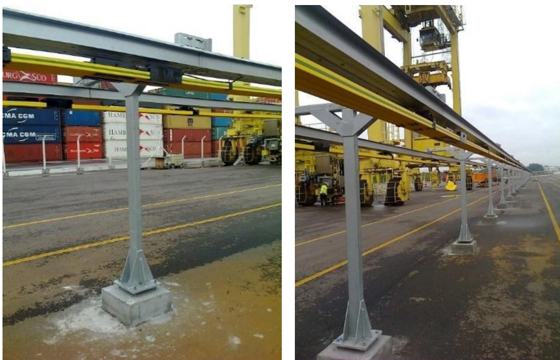
Figura 23 - Estruturas de condução dos RTGs.
