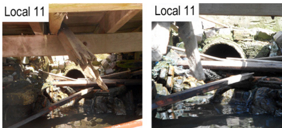
Figura 7 - Porto Velho (Rio Grande - RS): emissário pluvial por onde escoava fracamente um efluente contaminado com esgoto, possivelmente industrial/urbano.
