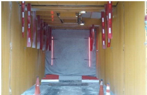
Figuras 17 e 18 - Sensores e sistema de luzes para posicionamento dos caminhões na moega
