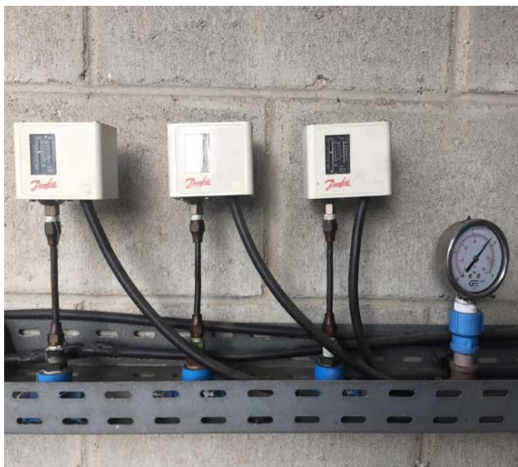
Foto 23 - Pressostatos e manômetro que controlam a pressão da rede de distribuição.
