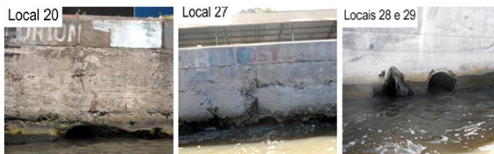
Figura 11 - Porto Novo (Rio Grande - RS): detalhes de 3 efluentes pluviais contaminados com provável ligação clandestina de esgotos.
