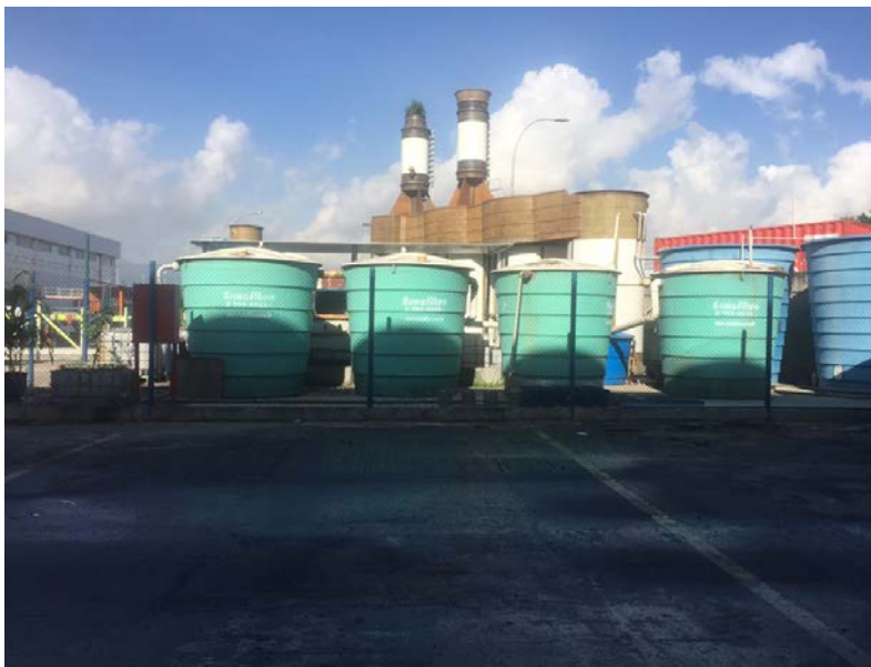
Foto 13 - Fossas sépticas com filtro anaeróbico.
