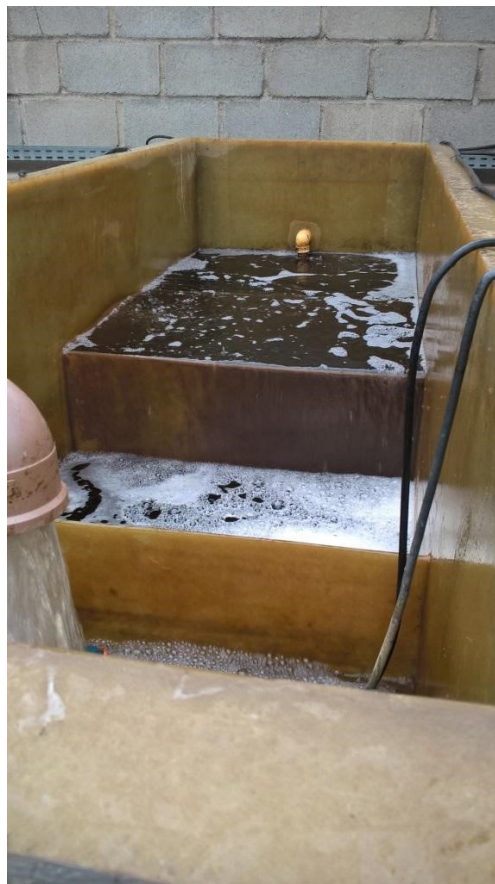
Foto 8 - Recirculação Água no Tanque de Ozônio
