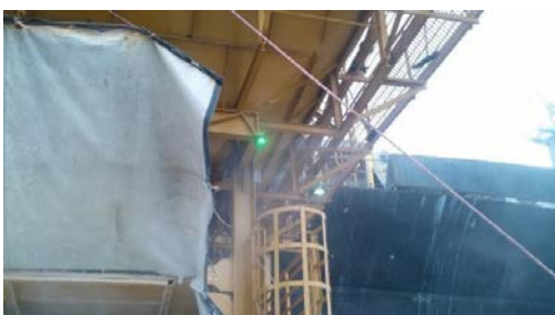
Figuras 8 e 9 - Luzes externas verde e vermelha para indicar moega aberta ou fechada
