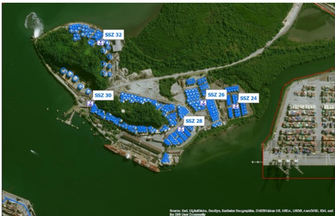
Figura 18: Margem Esquerda – Ilha Barnabé
