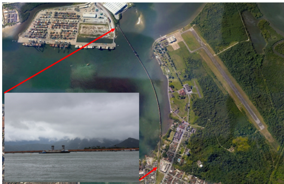
Figura 48: Ponte ferroviária sobre o Canal de Bertioiga
