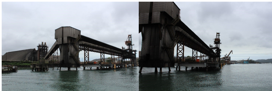
Figura 40: Infraestrutura de suporte ao transportador contínuo: TEAG, Porto de Santos
