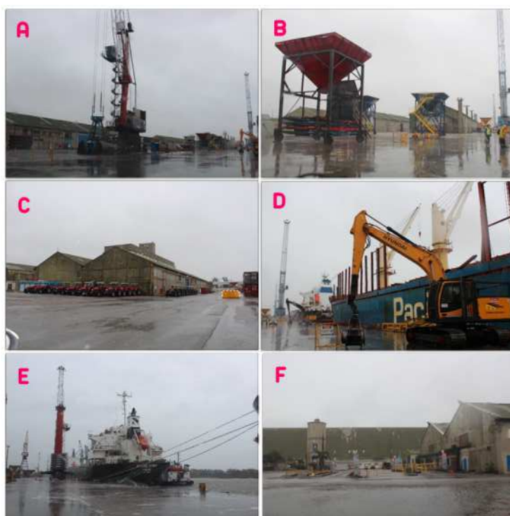
Figura 16: Registro fotográfico da visita técnica ao Porto Novo: A) guindaste portuário com grab para descarga de granéis; B) tremonhas para carregamento rodoviário; C) equipamentos agrícolas para embarque ro-ro; D) escavadeira para apoio operacional; E) vista do cais corrido e cabeços de estaiamento; e F) balança para veículos rodoviários de carga.
