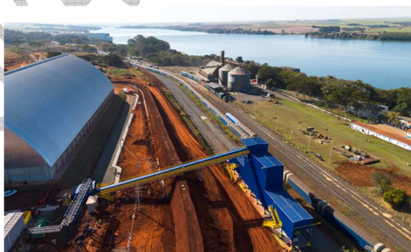
Figura 10 – TUP Terminal de Grãos de Pederneiras/SP.
