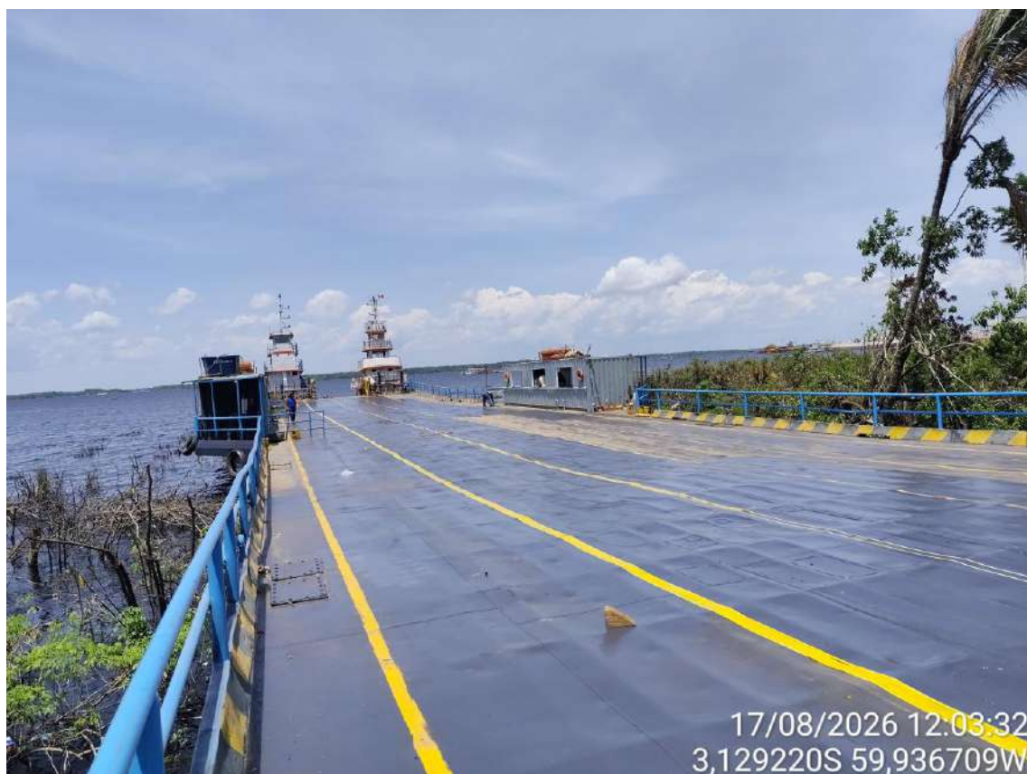
Foto 15 – Dispositivos para evitar a queda de passageiros (guarda corpo ou barras de apoio) na embarcação.
