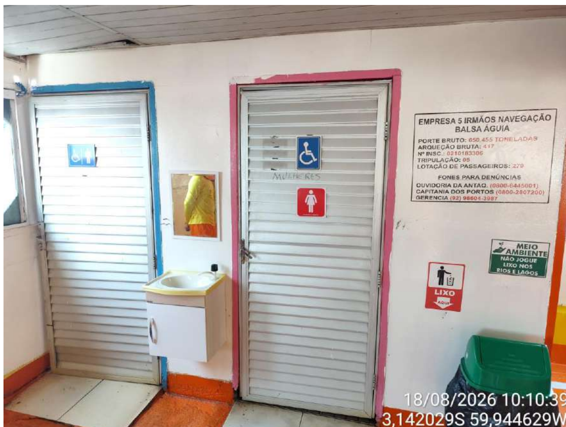
Foto 51 – Demais sanitários e lavatórios na embarcação.
