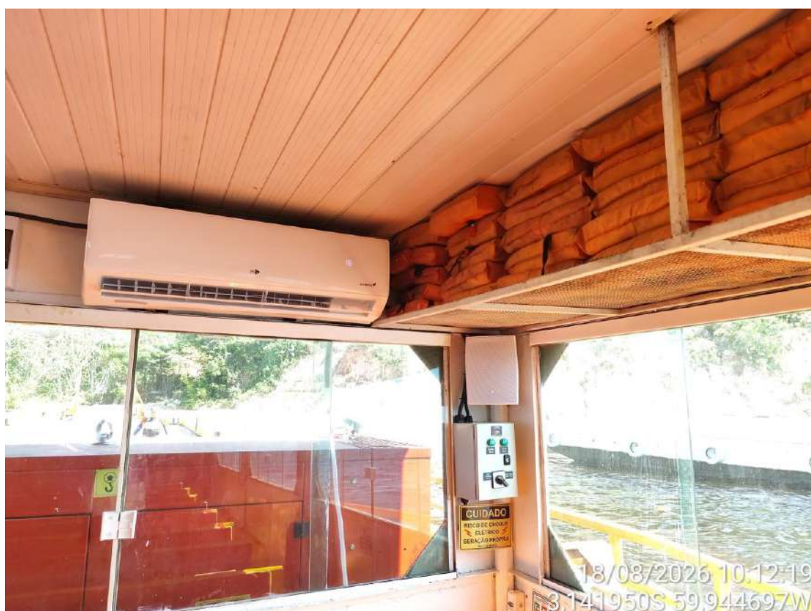
Foto 53 – Área da embarcação contendo ar-condicionado para os passageiros.
