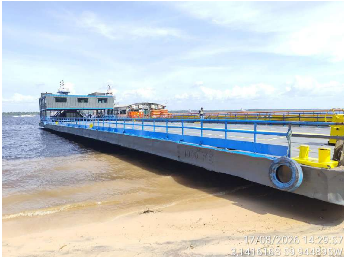
Foto 25 – Dispositivos para evitar a queda de passageiros (guarda corpo ou barras de apoio) na embarcação.
