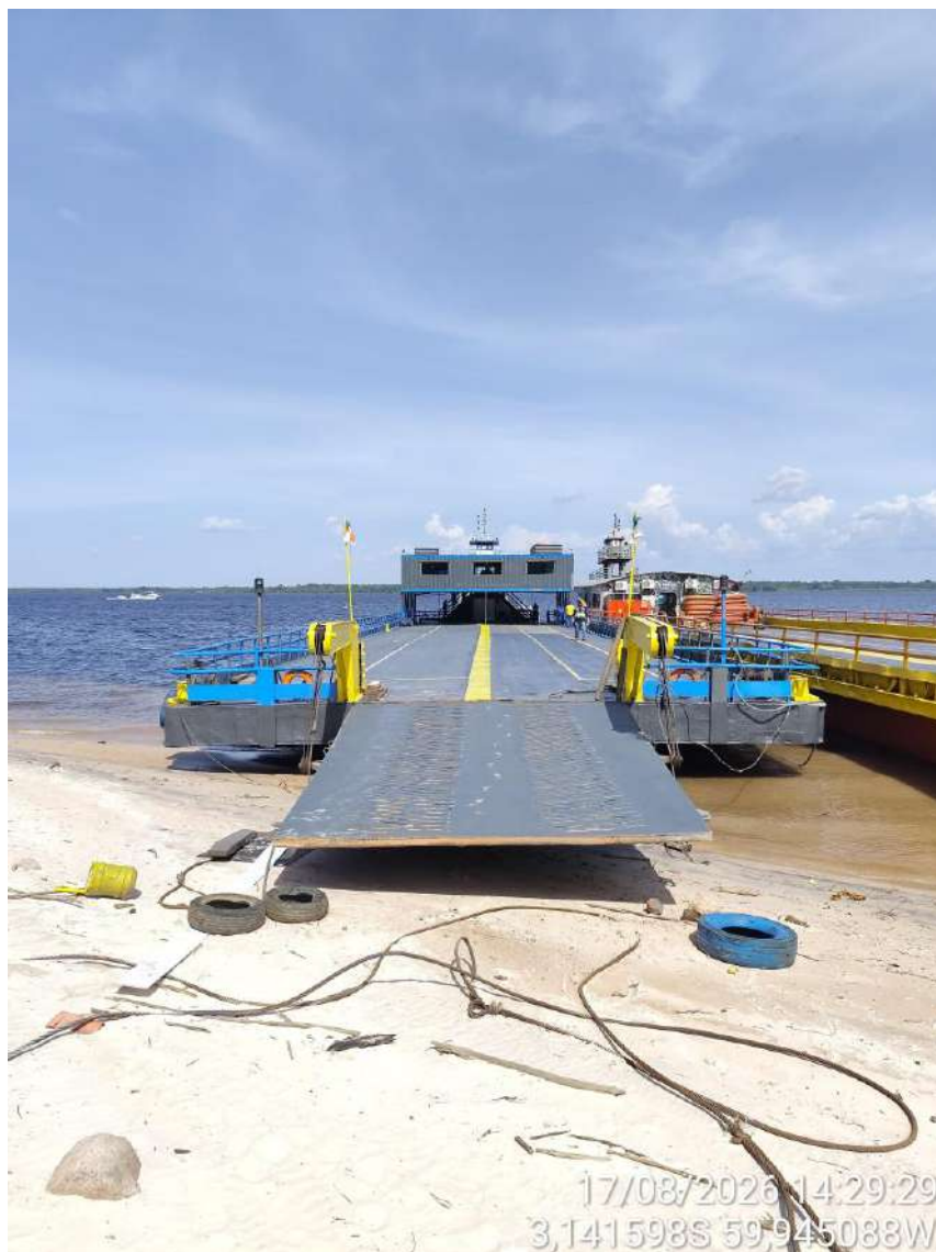
Foto 24 – Rampa de acesso da embarcação.
