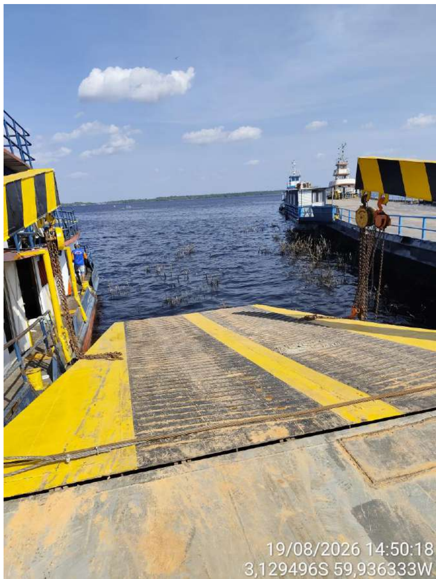
Foto 79 – Rampa de acesso da embarcação.
