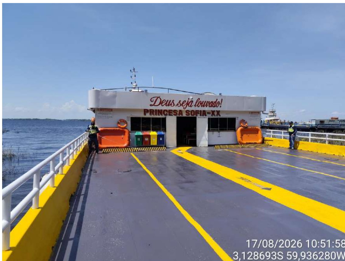
Foto 04 – Dispositivos para evitar a queda de passageiros (guarda corpo ou barras de apoio) na embarcação.
