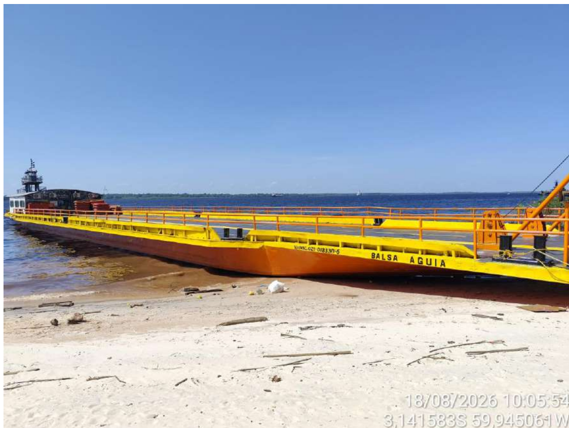
Foto 47 – Dispositivos para evitar a queda de passageiros (guarda corpo ou barras de apoio) na embarcação.
