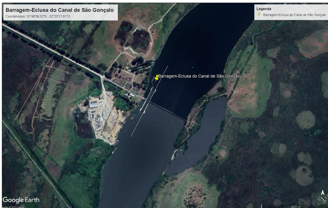
Figura 13 – Barragem-Eclusa do Canal de São Gonçalo.
