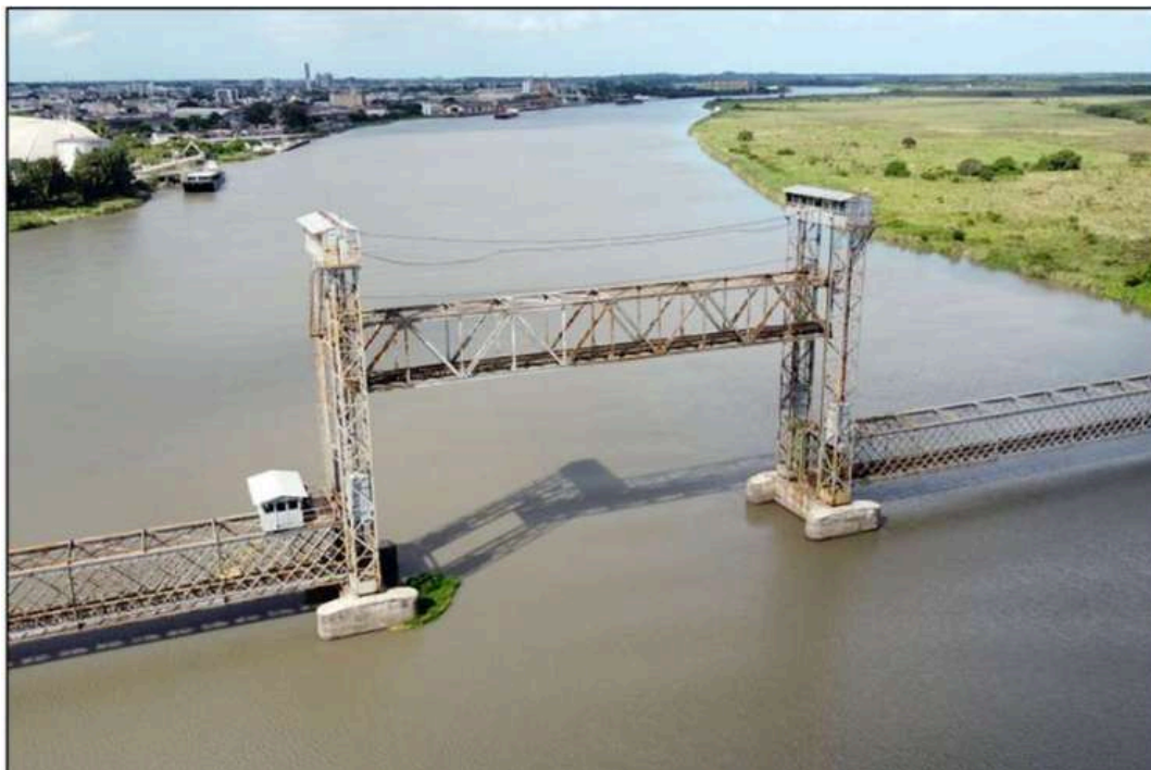
Figura 16 – Ponte Ferroviária sobre o Canal de São Gonçalo
