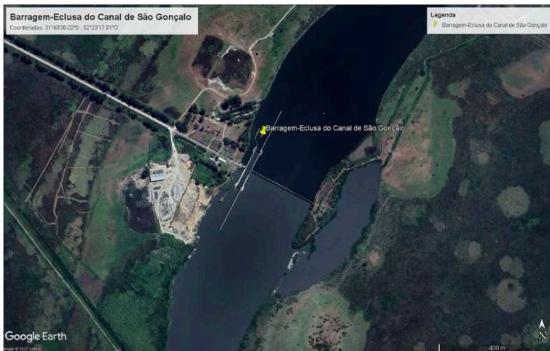
Figura 13 – Barragem-Eclusa do Canal de São Gonçalo.
