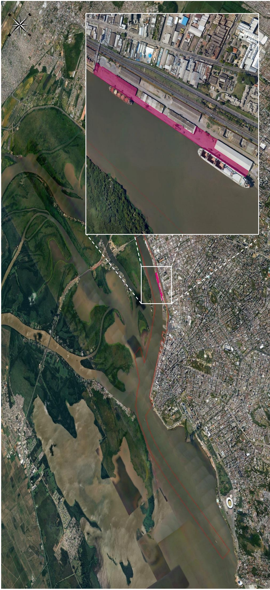
FIGURA 16 - Vista aérea do recinto alfandegado (linha vermelha: poligonal do porto organizado)
