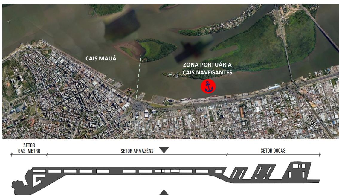
FIGURA 18 - Interface Cais Mauá e Cais Navegantes
