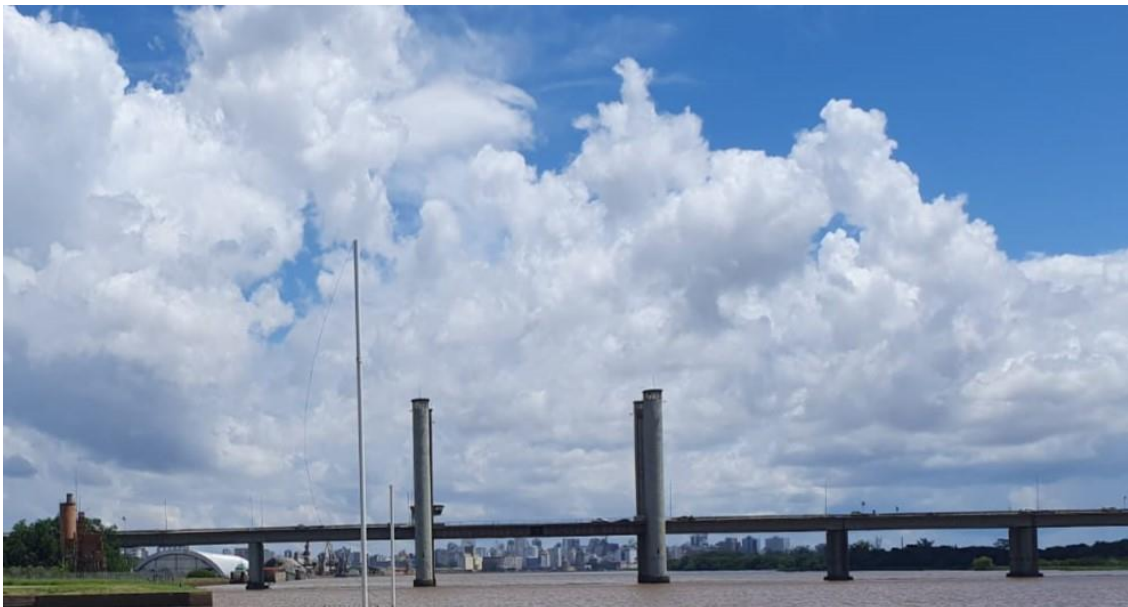
FIGURA 46 - Foto Ponte do Guaíba ( Travessia Getúlio Vargas)
