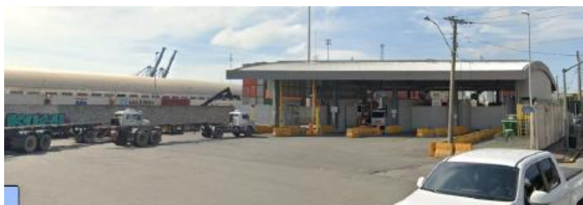
Figura 19 – Gate área pública Fonte: Consórcio Demarest
