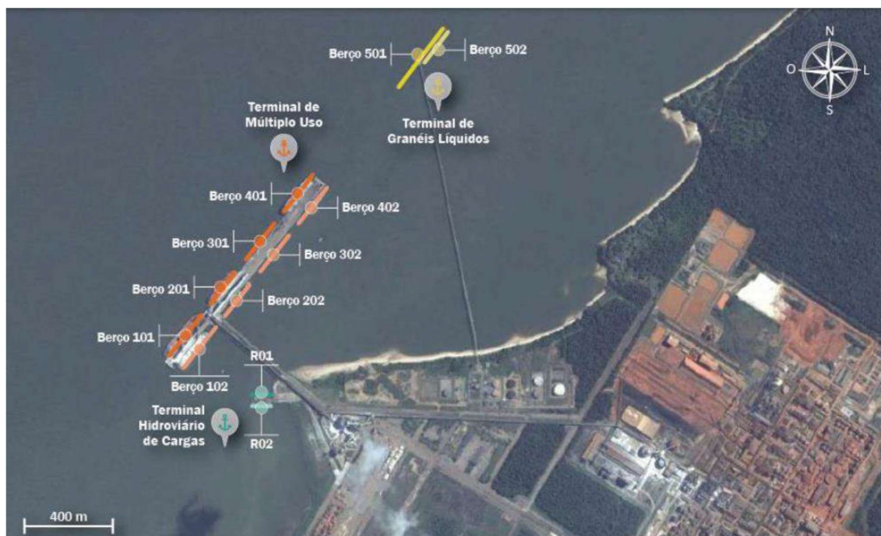
Figura 8 - Infraestrutura de acostagem do Porto de Vila de Conde.
