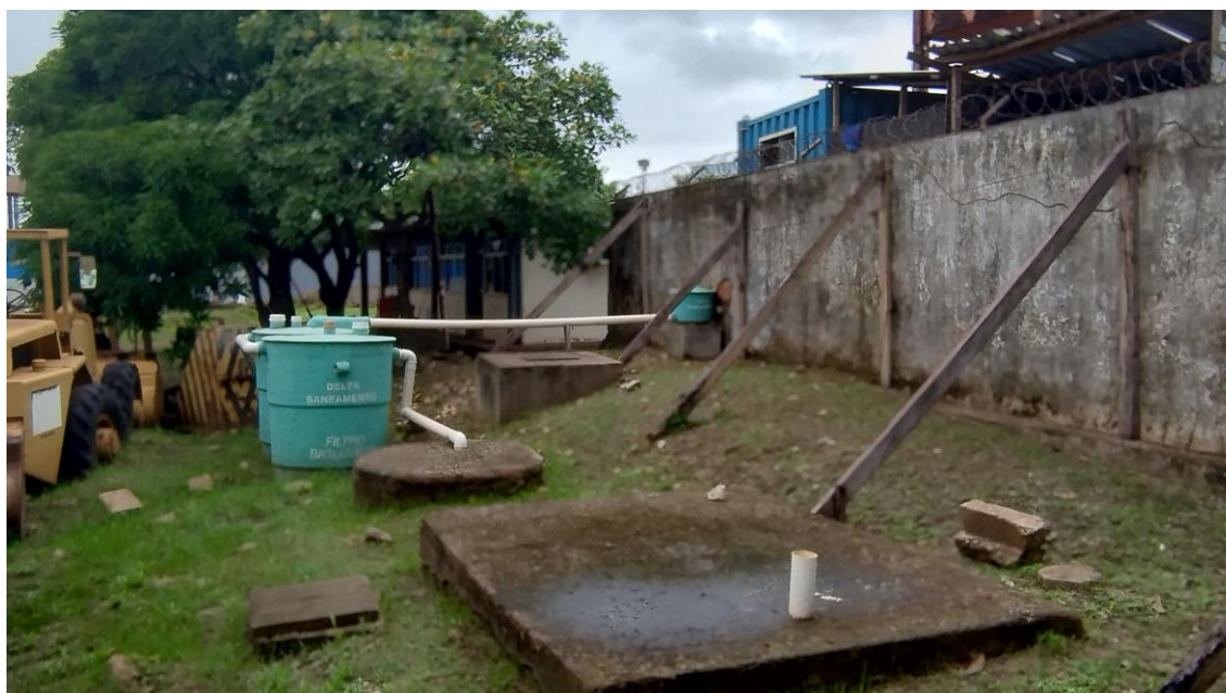
Figura 3 – Área de fossa séptica
