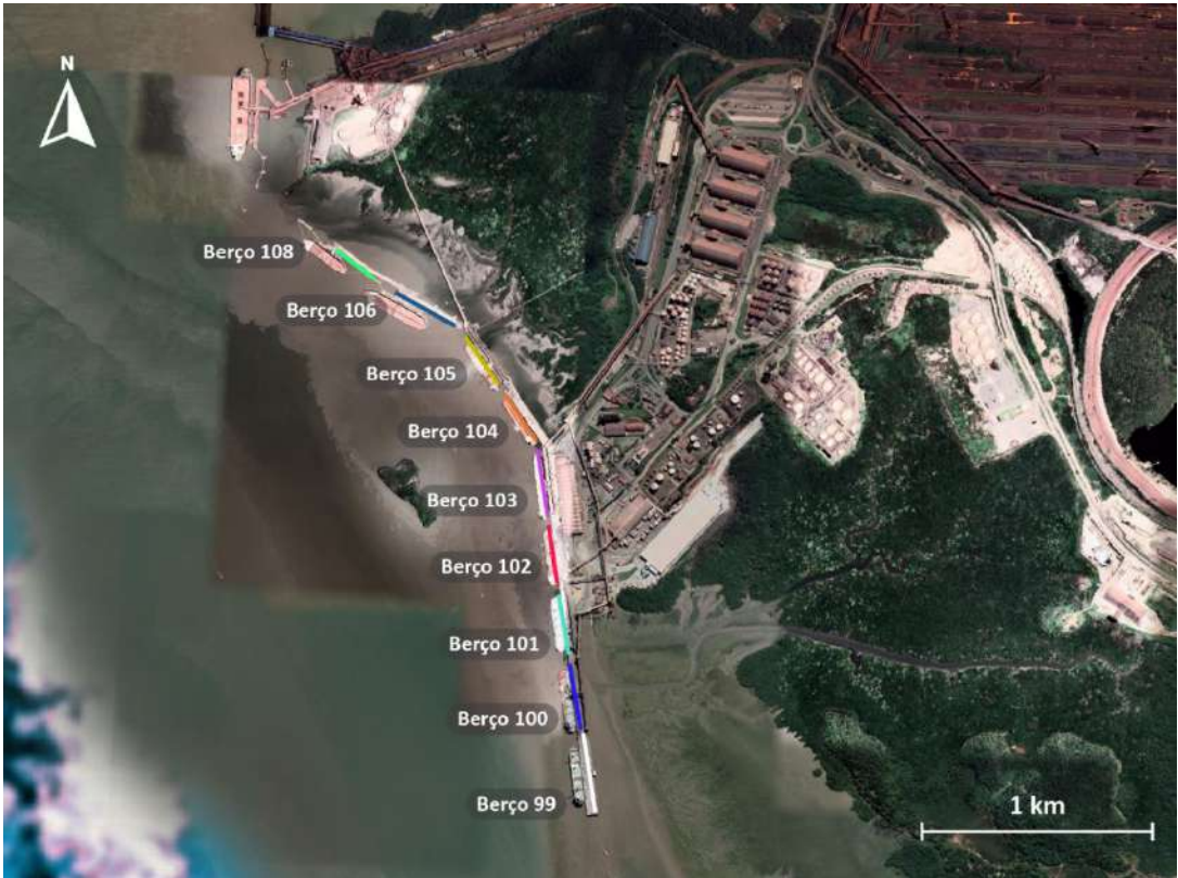
Figura 4 – Infraestrutura de acostagem do Porto do Itaqui
