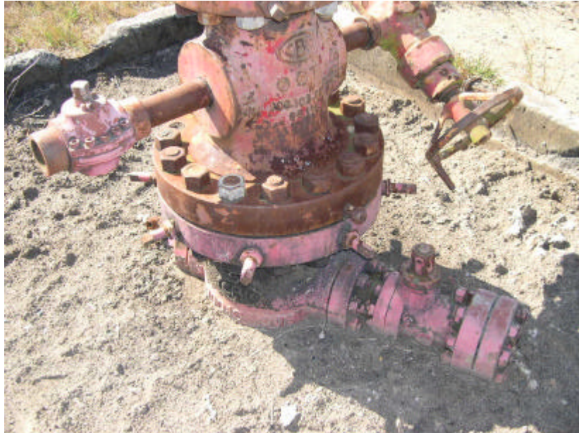
Foto 4 (Poço 1-BRSA-57-ES – detalhe da cabeça)
