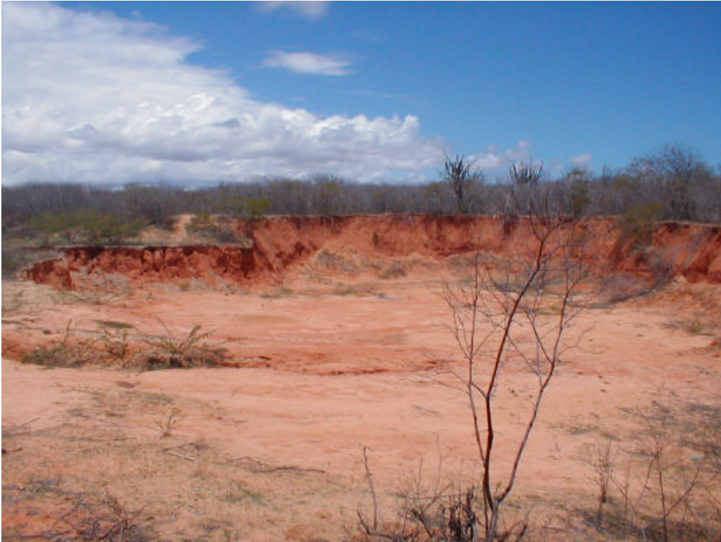
Foto 2 (Dique erodido na área do poço 1-PM-2-RN)
