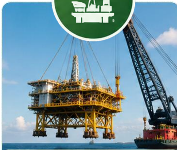
Remoção de instalações
