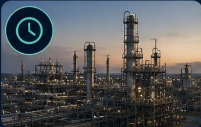
DETECÇÃO TARDIA DE EVENTOS E VAZAMENTOS
