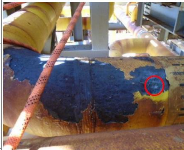
Foto 20: Corrosão de média intensidade com pit's
