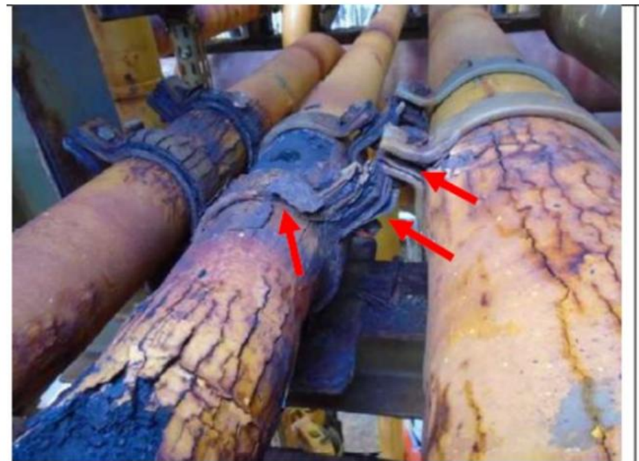
Ponto com elevada degradação, mas sem avaliação adequada da espessura (raio x, por exem
