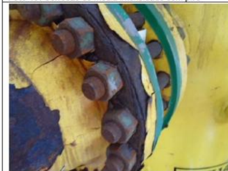
Foto 21: Corrosão de média intensidade
