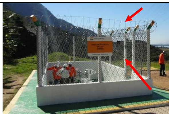
Fig. 4 - Entorno da área de válvulas antes e após a instalação de concertina
