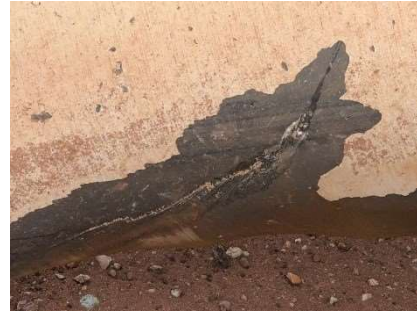
Figura 12 - Mossas e danos mecânicos devido a ação externa
