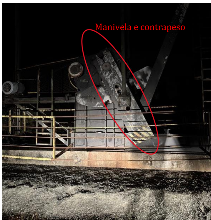
Figura 1 – Partes móveis da Unidade de bombeio mecânico que atingiram a vítima.
