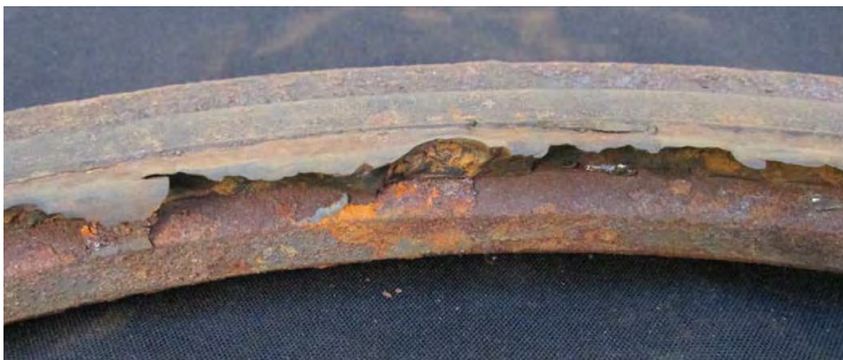
Figura 72 – Aspecto macroscópico do selo de vedação falhado, apresentando trincas no sentido longitudinal e fratura próxima à região de transição de contato com o fluido e com o meio externo
