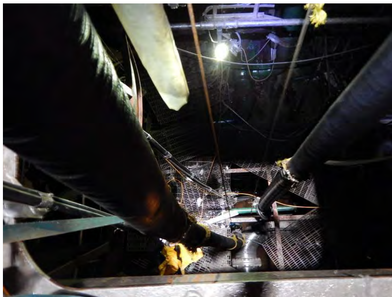
Figura 25 – Piso da sala de bombas
