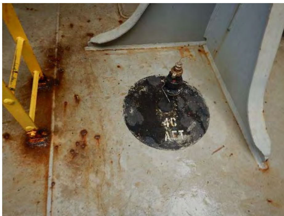
Figura 68 – Conexão para UTI no tanque 4C
