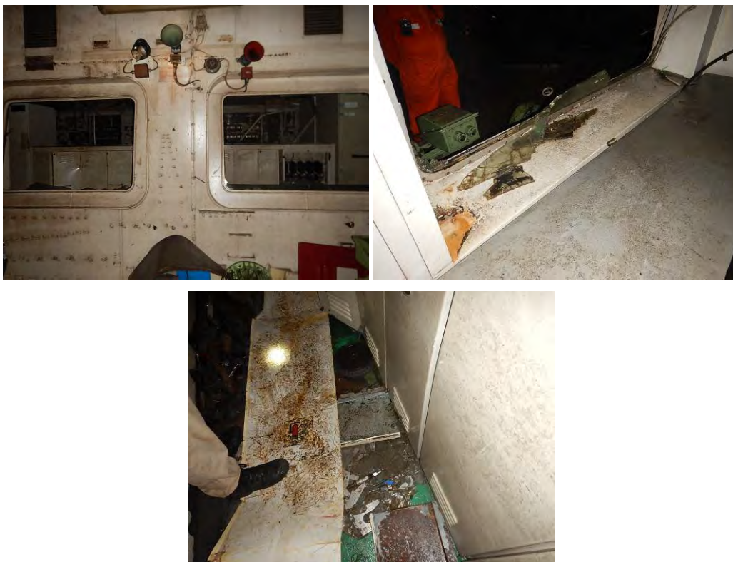
Figura 12 – Janelas da ECR (vidros quebrados e estilhaços dentro da sala)
