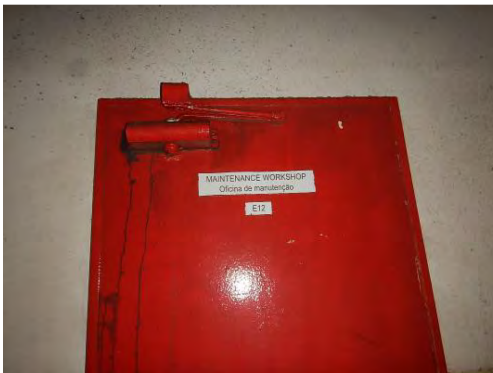
Figura 17 – Porta estufada da oficina de manutenção
