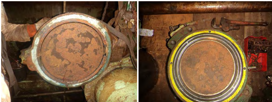
Figura 83 – À esquerda, válvula com seat ring degradado e à direita, válvula com seat ring substituído.
