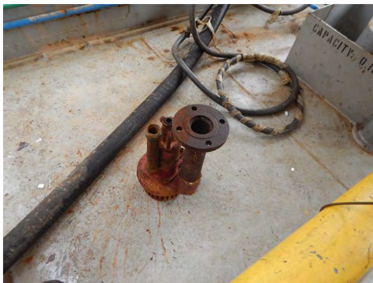
Figura 76 – Bomba submersível portátil utilizada para a transferência de carga entre tanques durante a mudança temporária
