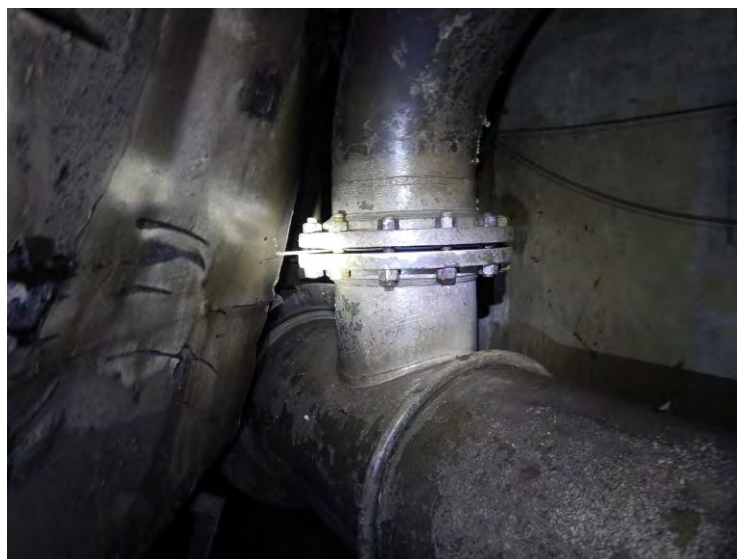
Figura 123 – Exemplo de raquete instalada em linha do sistema de transferência de carga
