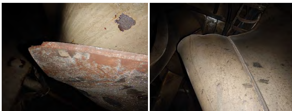
Figura 8 – Antepara entre a sala de bombas a praça de máquinas dobrada
