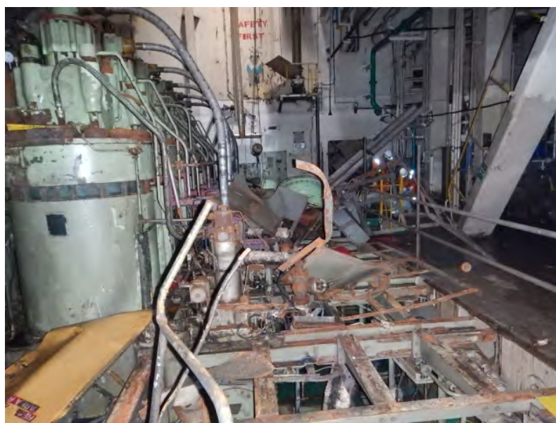
Figura 14 – Praça de máquinas após a explosão
