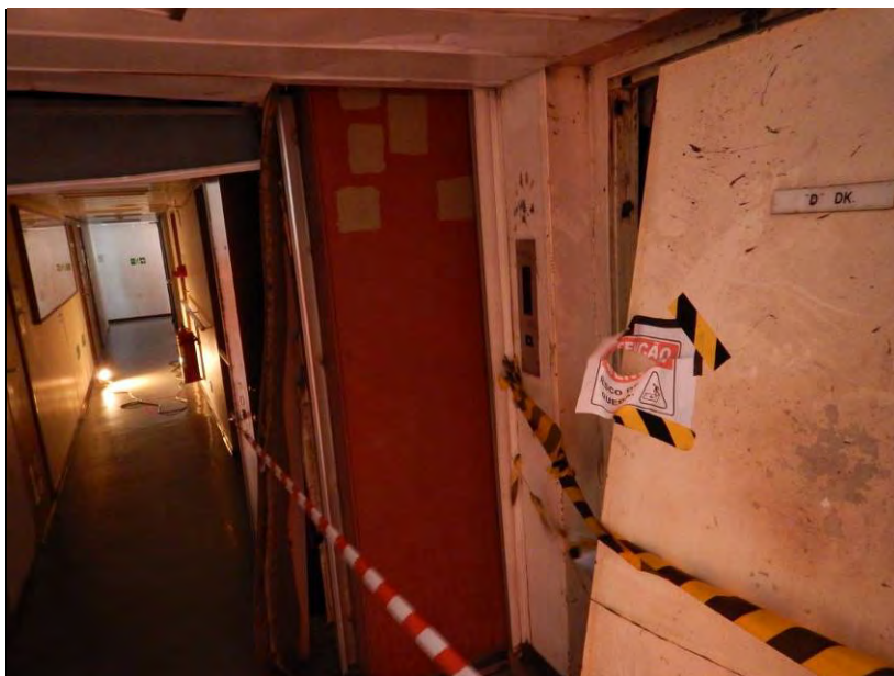
Figura 22 – Porta do elevador no nível “D” da unidade após a explosão
