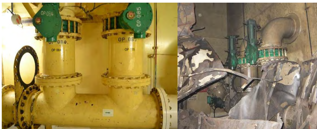
Figura 105 – Válvula OP-084 antes e após o acidente
