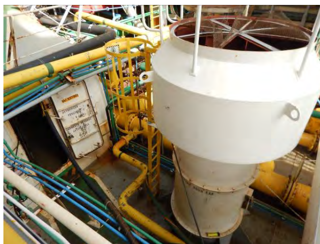
Figura 51 – Uma porta e um exaustor da casa de bombas
