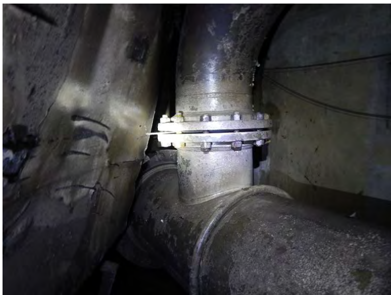
Figura 85 – Raquete instalada para isolamento da válvula BFV-1005
