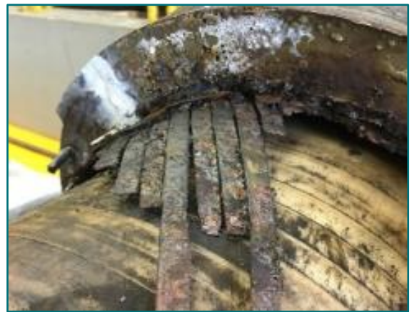
Figura 3 – Corrosão severa na armadura de tração da terminação do riser
