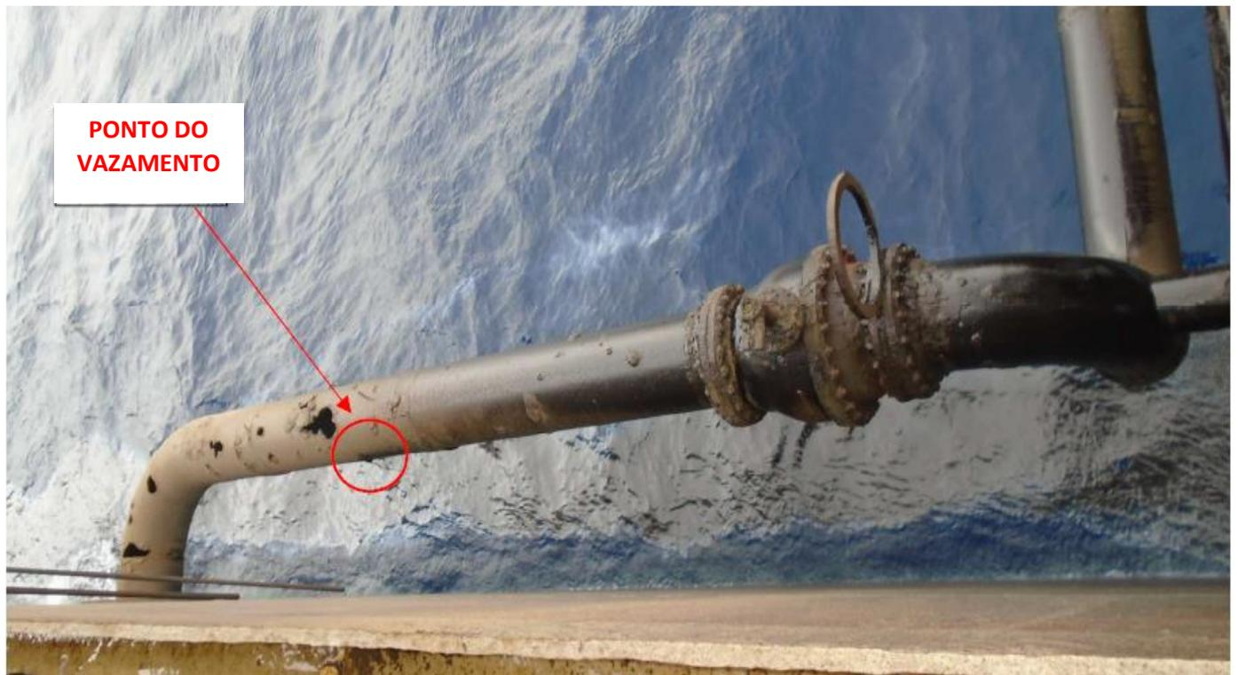
Após remanejamento do conteúdo do tanque que levou à queda do nível de óleo, o vazamento foi cessado.
