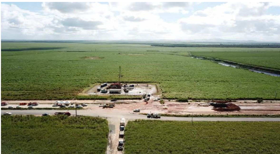
Figura 2 – Foto da localização do poço 7-ANB-16D-AL, que teve blowout próximo à rodovia
