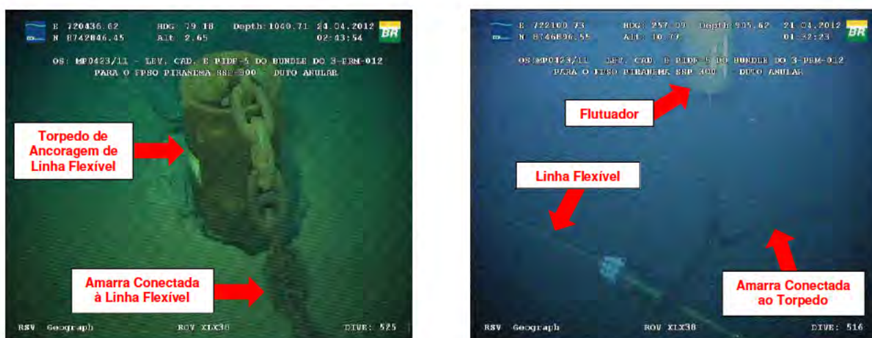
Figura 8: Ancoragem de linha flexível, destacando a estaca torpedo cravada (foto da esquerda) e a presença de flutuador (foto da direita) na amarra que conecta a linha flexível ao torpedo.
