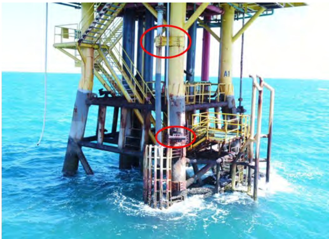
Figura 3.3-III – Fixação dos risers de dutos na jaqueta de PCM-2
