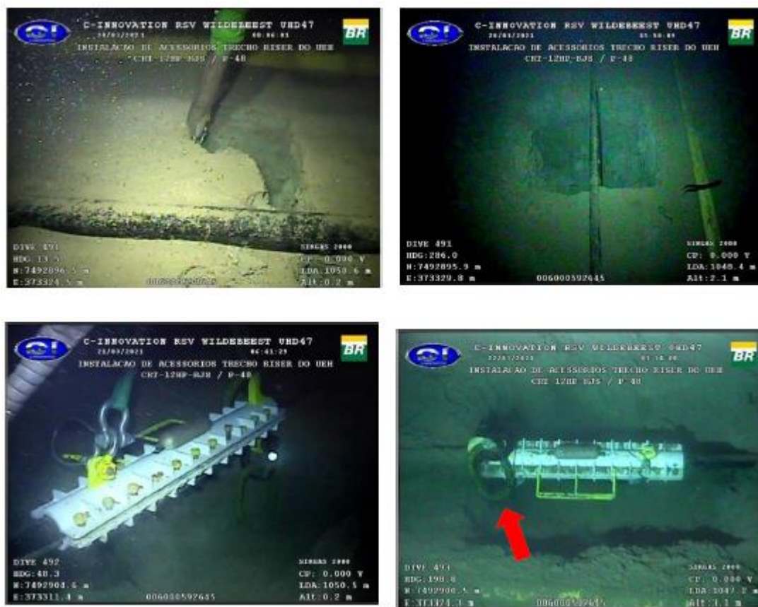
Figura 5.3.2-IX - Fotos mostrando diferentes momentos da operação de preparação (dragagem) e instalação da ferramenta especial de içamento de linhas cortadas em um umbilical. Destaca-se que a ferramenta é descida e posicionada com auxílio do guincho / guindaste da embarcação. A seta vermelha mostra o anel no qual a lingada proveniente do PLSV será conectada para realizar o içamento da linha para a embarcação, permitindo o seu recolhimento.
