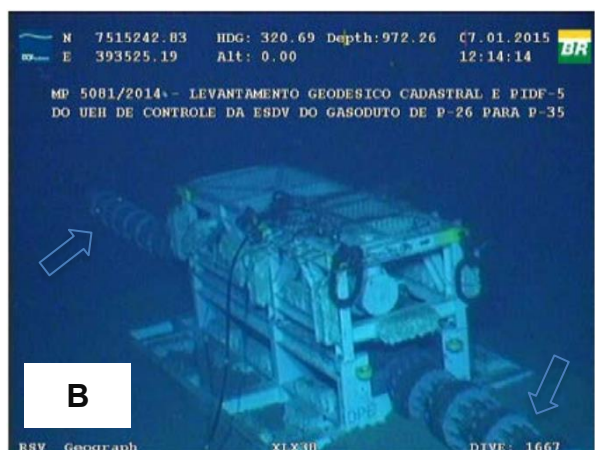
Figura 3.4-I – (A) Cacho de amarra conectado à Caixa de Junção (CJ) do umbilical do poço 8-MRL-61A, interligado à P-26. (B) ESDV do gasoduto da P-26 para a P-35. A válvula está montada in line entre dois tramos (indicados pelas setas) do gasoduto (duto flexível).
