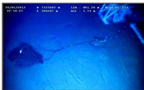
Figura 5.2-II - Imagem de ancoragem de duto flexível por meio de cacho de amarra posicionado no leito marinho
