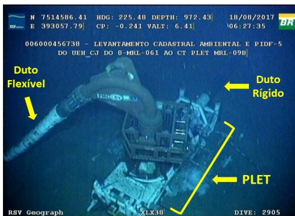
Figura 3.4-III - Fotos mostrando o PLET-MRL-09B, responsável pela interligação entre os trechos flexível.
