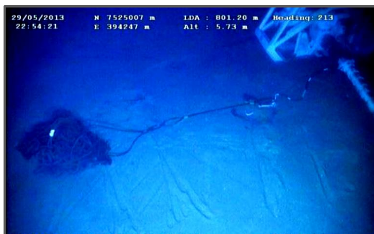
Figura 5.3.2-IV - Imagem de ancoragem de duto flexível por meio de cacho de amarra posicionado no leito marinho
