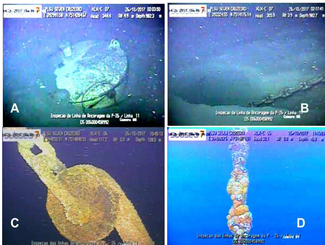
Figura 3.2.3-V - Componentes da linha de ancoragem #11: A. Estaca de sucção; B. TDP - conexão da estaca com amarra não visível; C. Conexão cabo sintético x rabicho de amarra; D. Final de inspeção.
