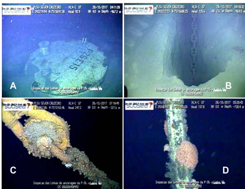
Figura 3.2.3-VI - Componentes da linha de ancoragem #11: A. Estaca de sucção; B. TDP - conexão da estaca com amarra visível; C. Conexão rabicho de amarra x cabo sintético; D. Vida marinha.
